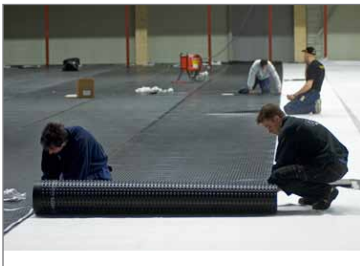
Bild på montering i idrottshall
