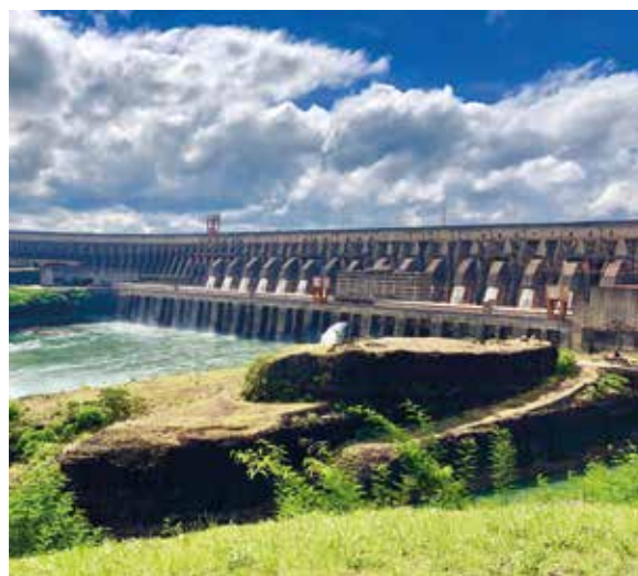
Velkou část energie zajišťují pro Brazílii vodní elektrárny, z nichž největší je projekt Itaipú na řece Paraná.
