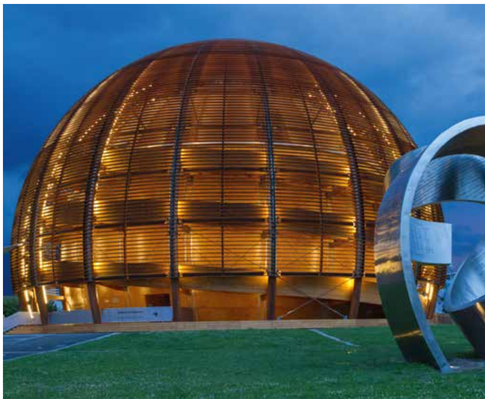
Centrální komplex CERNu sestává nejen z vědeckých laboratoří, ale také z rozsáhlého kancelářského a ubytovacího zázemí pro pracovníky.
