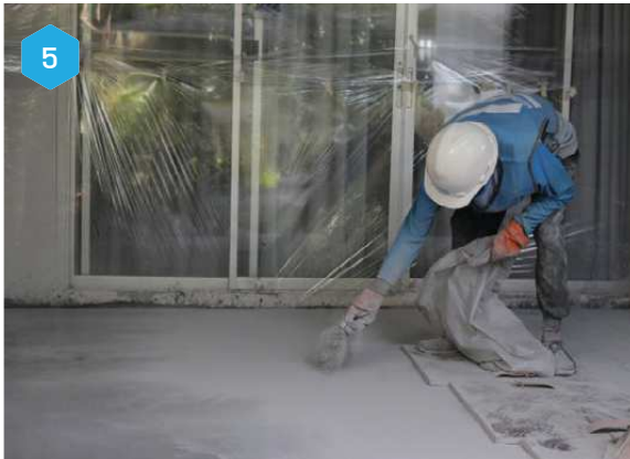
ทั้งคอนกรีตให้แข็งตัว จากนั้นโรยผงลอกแบบ (Release agent) บนผิวหน้าก่อนทำการพิมพ์ลาย
