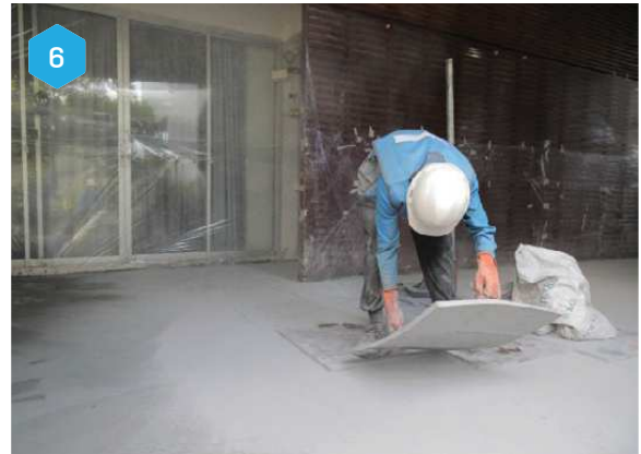
วางแบบแม่พิมพ์ลงบนลานคอนกรีตแล้วเริ่มพิมพ์ กดลายต่อกันไปเรื่อยๆ จนเต็มบริเวณที่กำหนด จากนั้นทำการเก็บรายละเอียดตามขอบพื้นที่ให้เรียบร้อย หลังพิมพ์ลายเสร็จแล้ว
