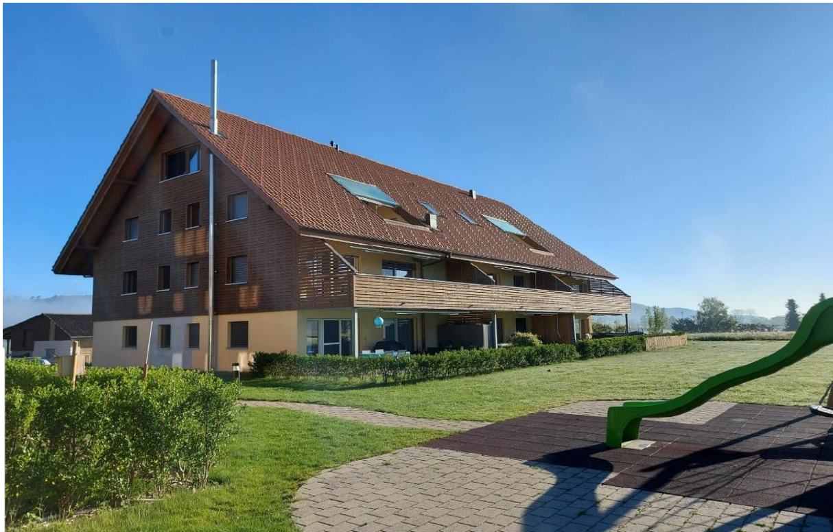
Südwest Ansicht, grosser Balkon im 1. OG
