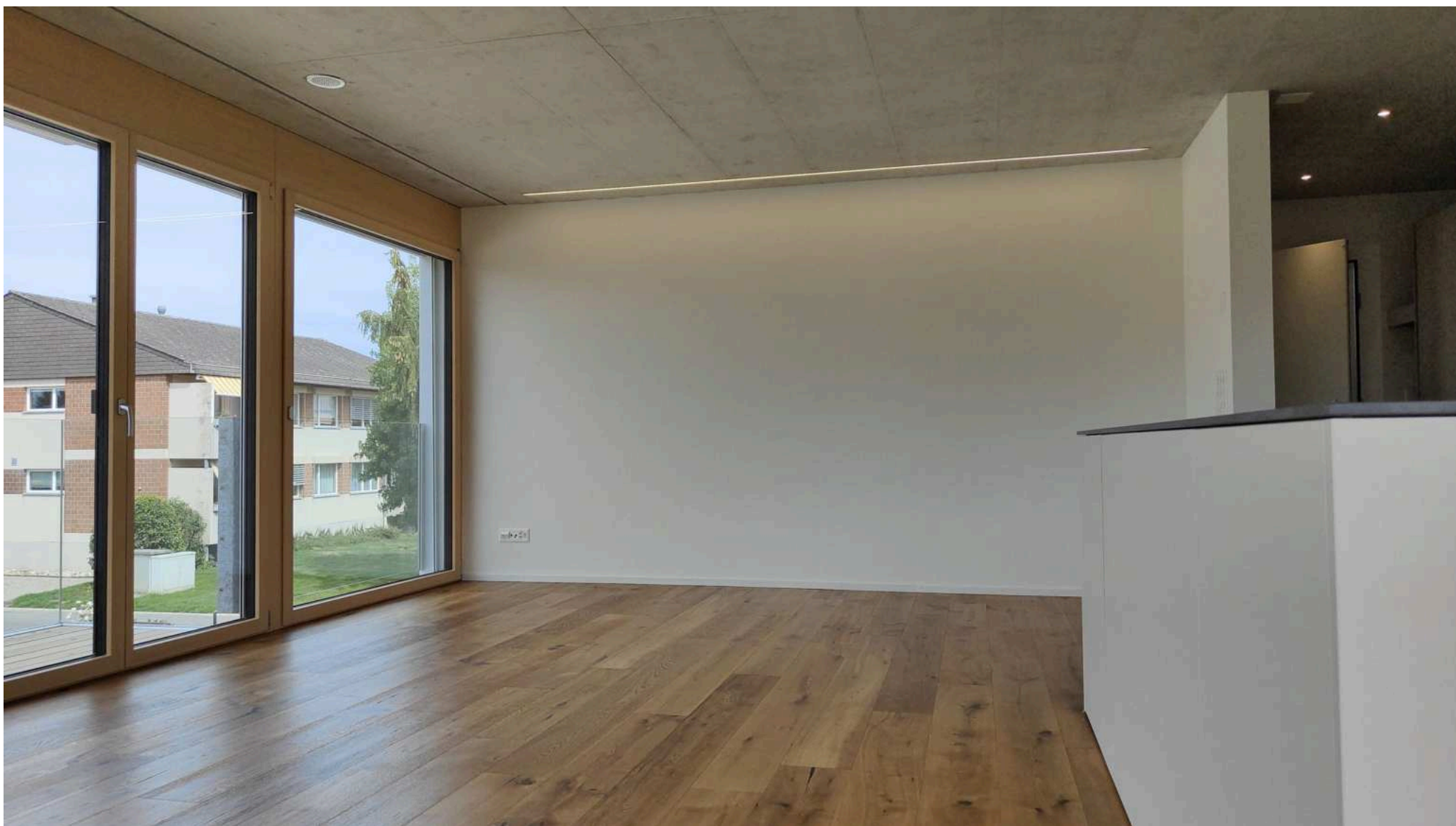
Ledstreifen an der Decke im Wohnbereich
