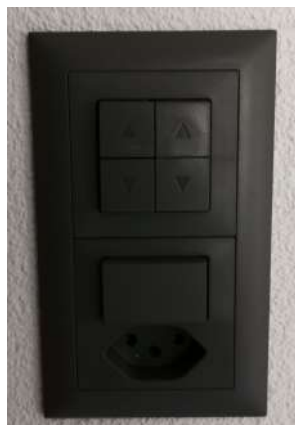
Abbildung 11: Elektrische Installationen, Archiv Holzbau AG
