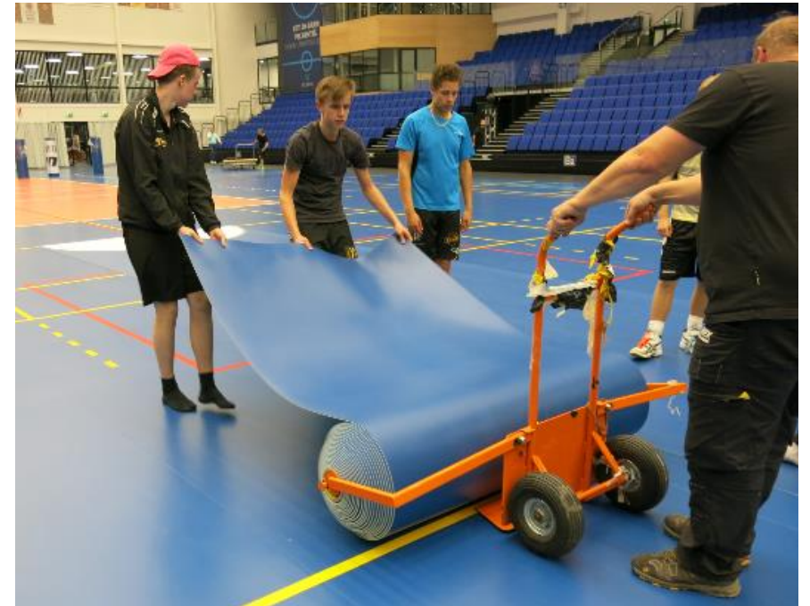
Kuva 26: Mattovuotien levittäminen matonlevityslaitteella: ensimmäiset 4-8 metriä käsin aukirullaten ja asemoiden - loppu levityslaitteella ”peruuttaen”
