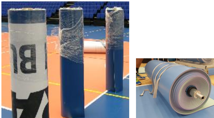
Kuva 48: Mattorullat ”suljetaan” käyttöön suunnitelluilla tarranauhoilla tai pakkauskelmulla. Tarvittaessa voidaan käyttää myös sauma- tai rajateippiä.
