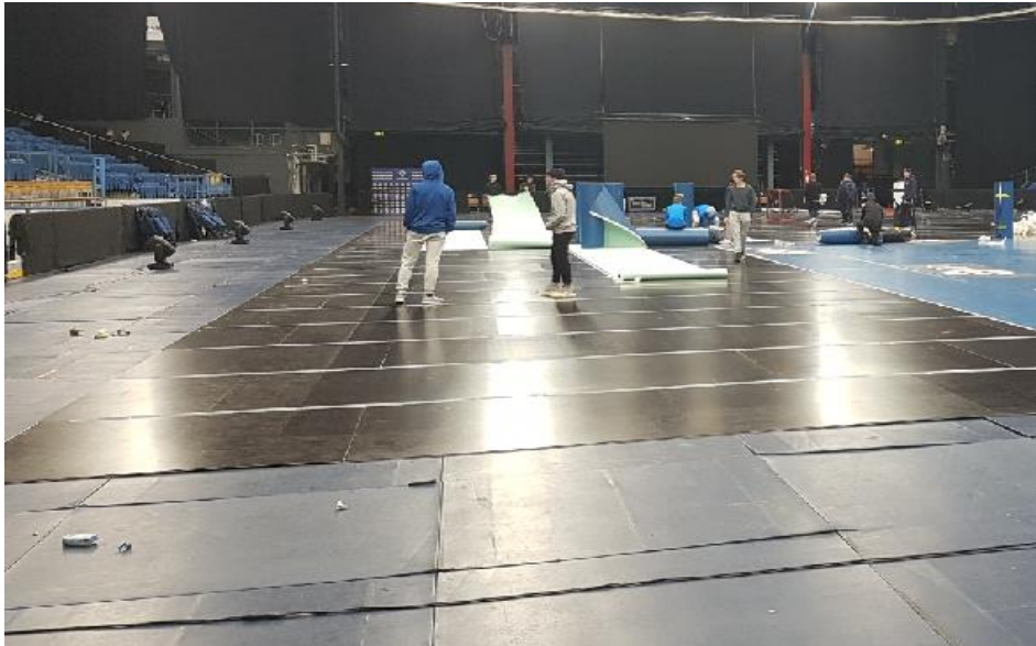
Kuva 14: Jään päälle asennettaessa, parhaan lopputuloksen aikaansaamiseksi, on koko jään alue eristettävä huolellisesti tarkoitukseen erikseen suunnitelluilla jäänpeittoeristelevyillä.
