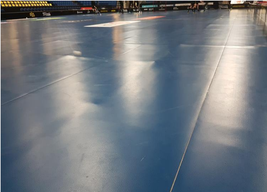
Kuva 11: Asennusalustamateriaalin suoruus ja tasaisuus on varmistettava aina ennen asennusta, sillä siirtomatto itsessään ei alla olevia epätasaisuuksia peitä vaan pikemminkin korostaa niitä.
