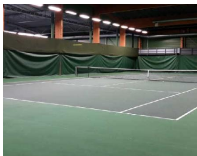
Kuva 15 : EI NÄIN - siirtomattoa ei suositella asennettavaksi suoraan pehmeän nukkamattopinnan päälle
