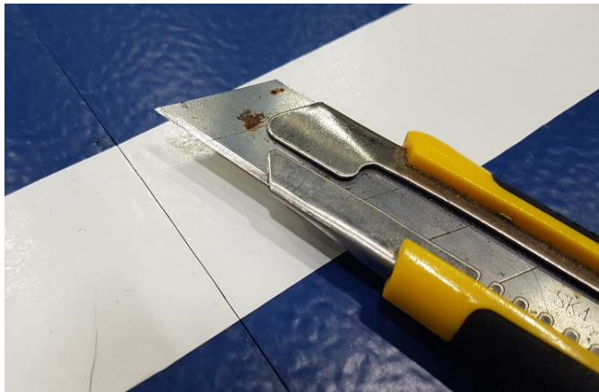
Kuva 44: Ennen siirtomaton purkamista varmistetaan, että mattovuotien saumakohtien rajateippaukset on "avattu".
