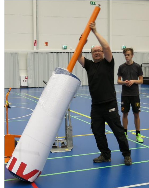
Kuva 20 : Mattovuodan ”kellistäminen” tai pystyynnostaminen onnistuu hallitusti käyttämällä maton levityslaitteen akselia ”vipuvartena”
