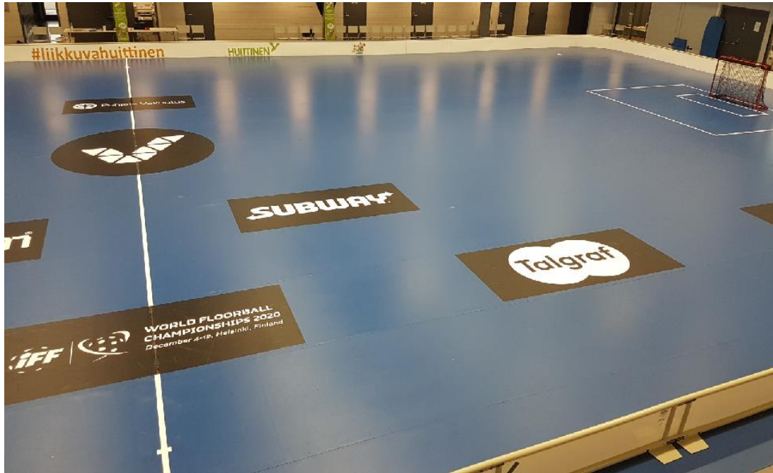
Kuva 23: Onnistuneen siirtomattoasennuksen kruunaavat mattomainos- kartan mukaisesti asennetut mainostarrat ja mittojen mukaiset rajateippaukset.
