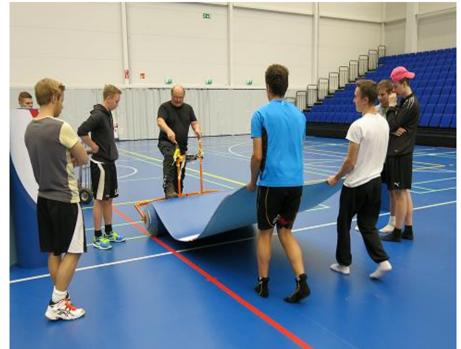
Kuva 2: Siirtomatto voidaan asentaa myös suoraan toisen synteettisen pelialustan päälle. Käynnissä maton levityslaitteen käytönopastus.
