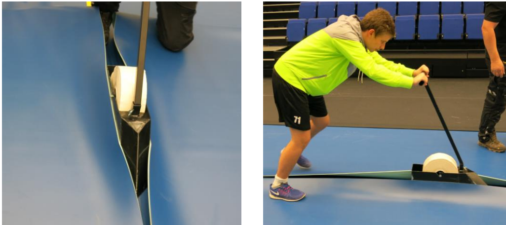
Kuva 30 ja 31: Saumateippaus aloitetaan toisesta kenttäpäädyistä sujauttamalla teippauskoneen keula mattojen väliin, minkä jälkeen kyseessä onkin enemmän tarkkuusajo kuin voima- tai nopeuslaji.
