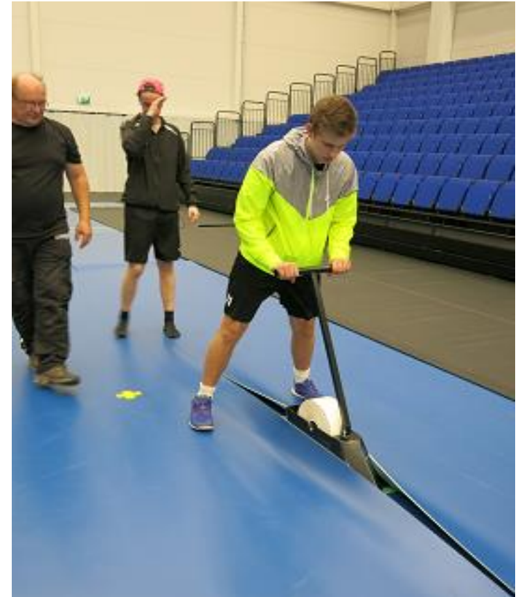
Kuva 4: Saumateippauskoneen ajo on tarkkaa puuhaa.
