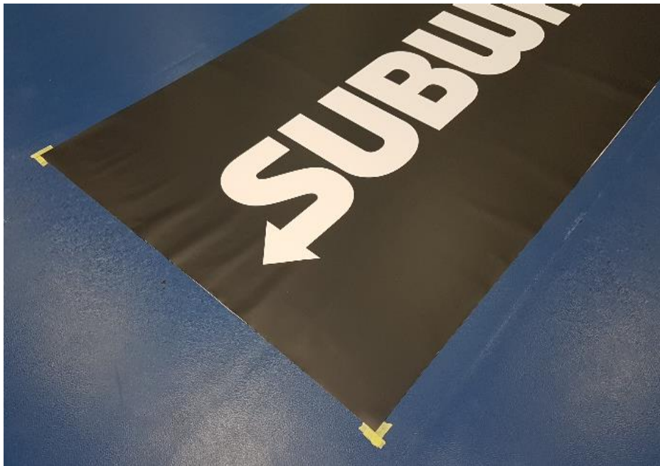
Kuva 36: Mainostarrojen ulkokulmat merkitään mattoon ennen asennusta maalarinteipillä.
