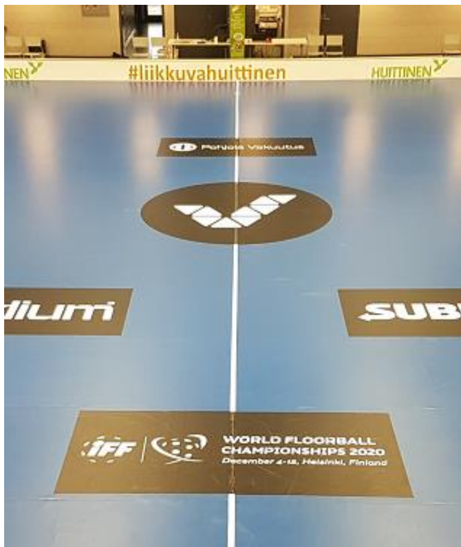
Kuva 34: Rajateippaus onnistuu parhaiten parityönä – sekä mittauksen/merkintöjen kuin myös varsinaisen teippauksen osalta.
