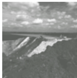
Mise en place des terres inertes sur l'ISDI de Moissy-Cramayel, 2019
