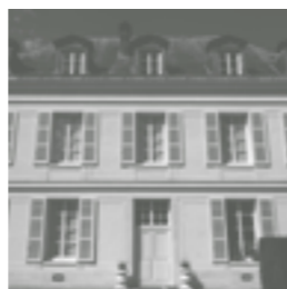
Pavillon La Quintinie, lieu d'accueil des résidents Villa Le Nôtre au Potager du Roi
