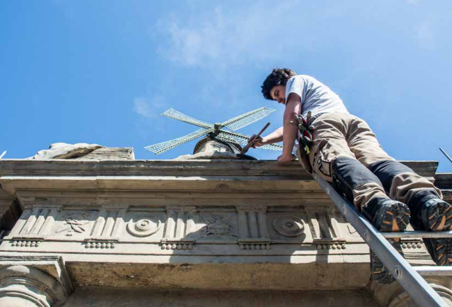
De stenen volmolen boven de poort aan de Oude Singel wordt gekleurd in een colourwash, die dichtbij de kleur van de steen staat.
