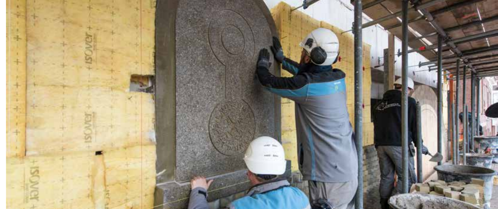
De gevelsteen met daarin het lakenloodje van de huisstijl wordt in de gevel aan de Lammermarkt ingemetseld.
