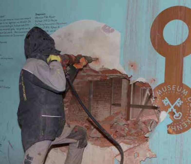
In de muur van de oude hal wordt de historische doorgang voor het raam naar de Achterplaats weer open gemaakt. Foto Buro JP
