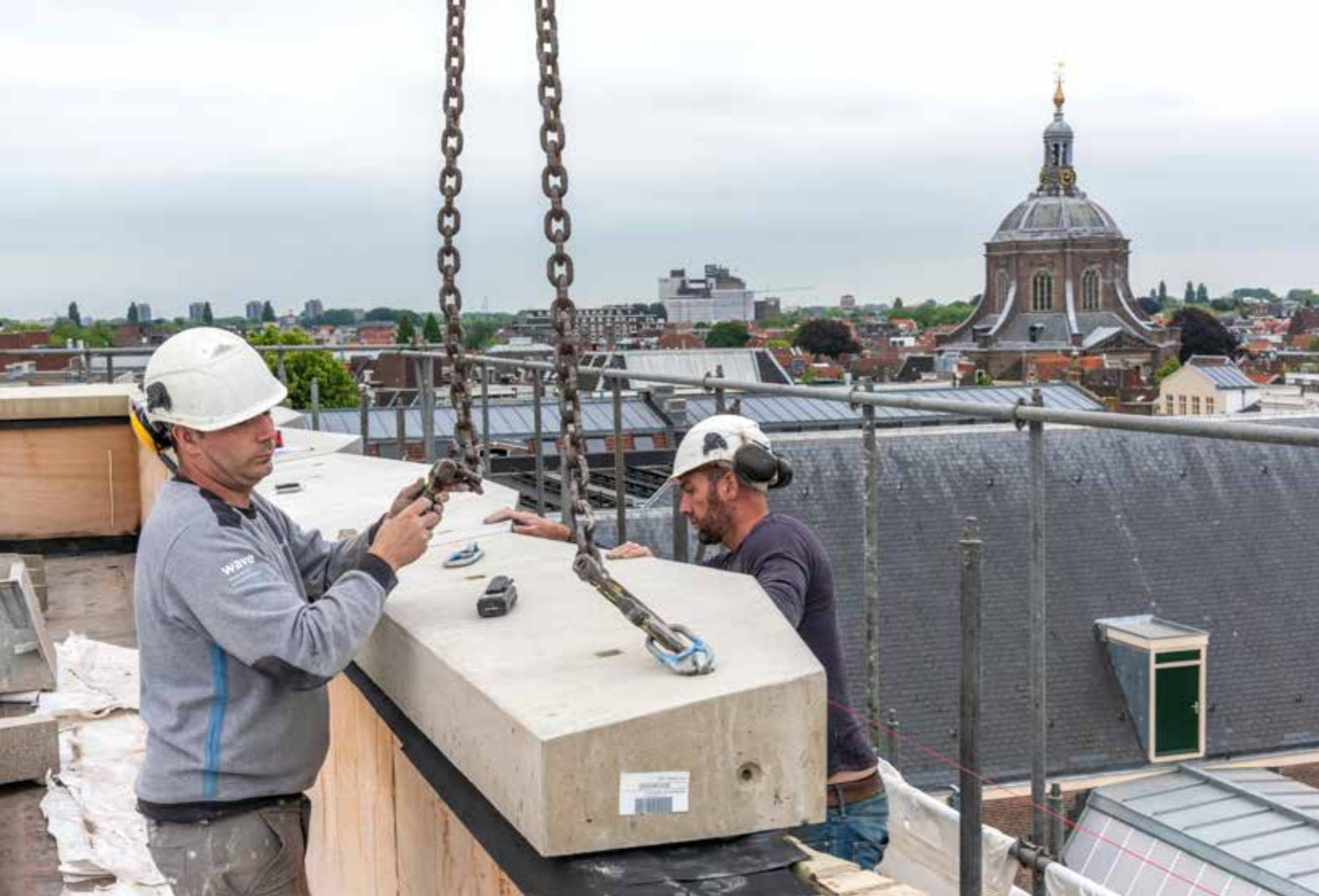
Bovenop het dak van de nieuwbouw aan de Lammermarkt wordt de betonnen afwerking in gereedheid gebracht.
