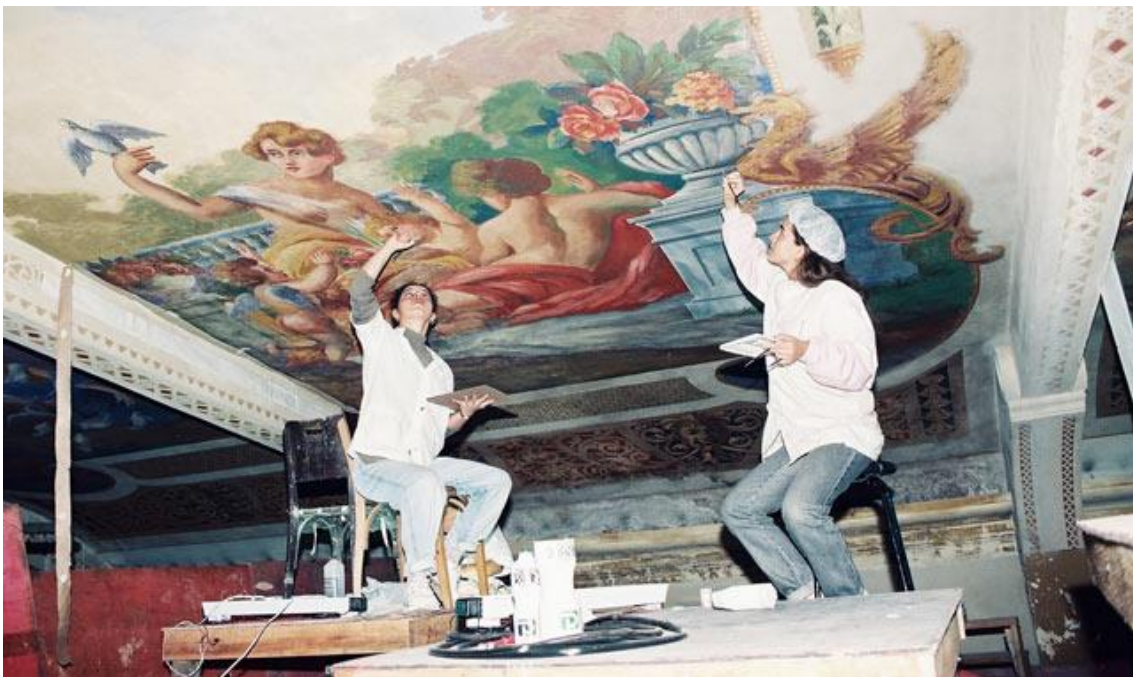
11.30. Restauração do teto do Central em 1996. Fonte: Groia, Franco. “ Reforma do Cine Theatro Central ”. 2010. Acesso 23 abr. 2022.
