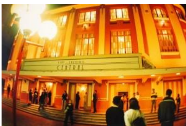
11.32. Foto noturna da fachada do Central, 2014~2018. Fonte: Cine – Theatro Central/Alexandre Dornelas . Acesso 23 abr. 2022.
