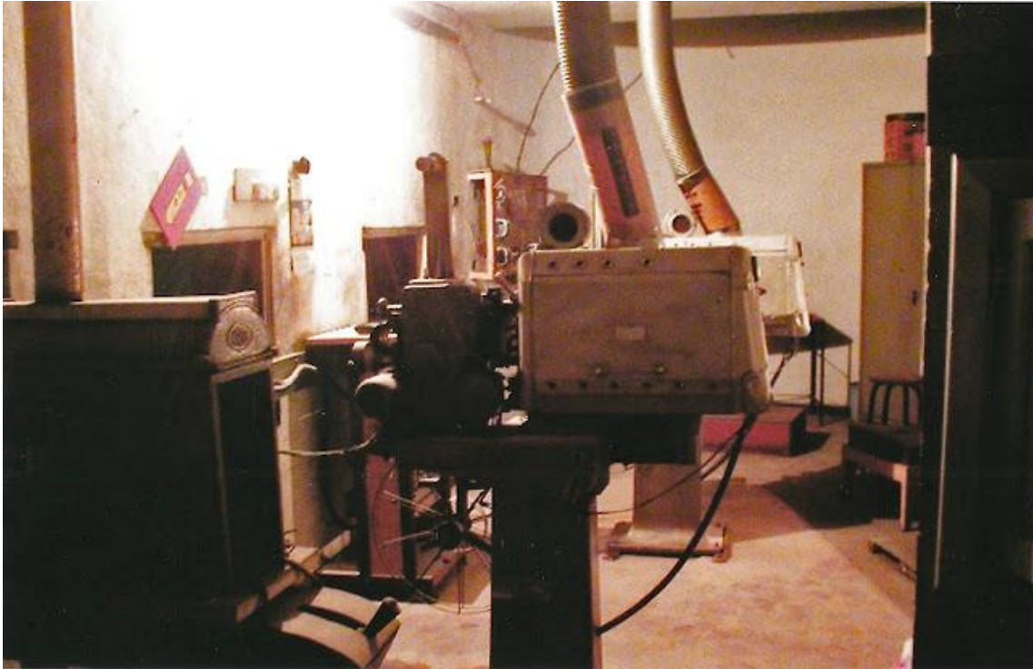
24.13. Excelsior em 2003, sala de projeção. Fonte: Site “ Maria do Resguardo ”. Acesso 03 abr. 2022.
