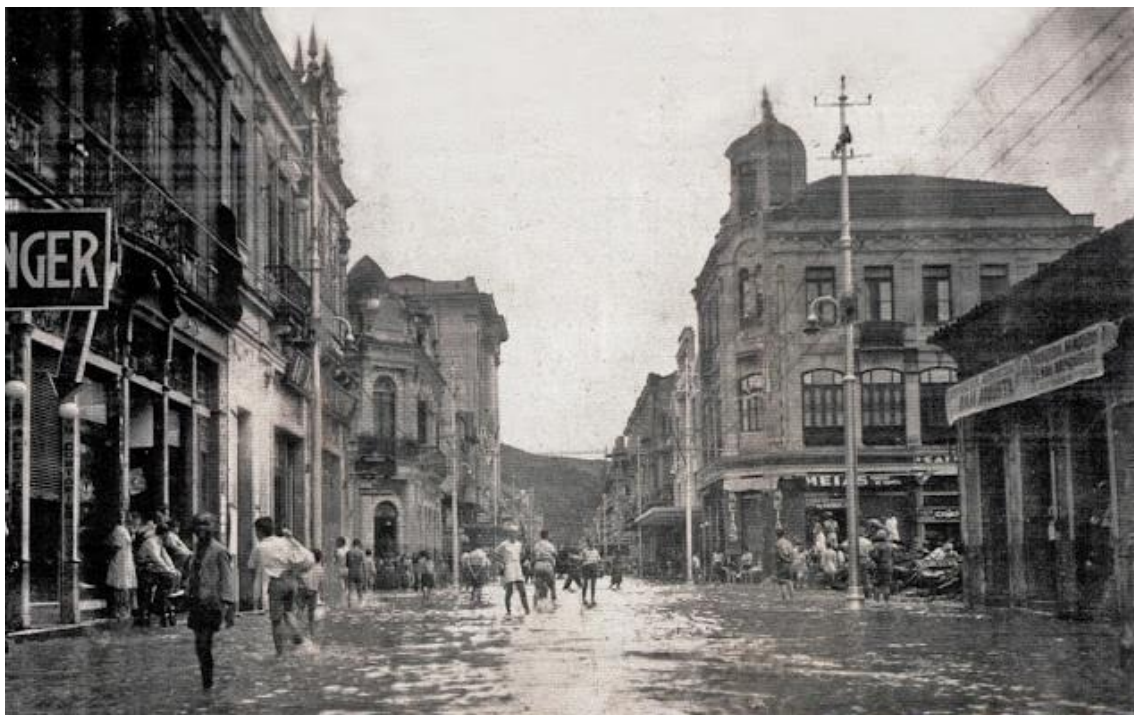
15.2. Rua Halfeld com Batista de Oliveira na enchente de 1940 - local onde seria construído o Cine Palace. Fonte: Site “ Maria do Resguardo ”. Acesso 03 abr. 2022.
