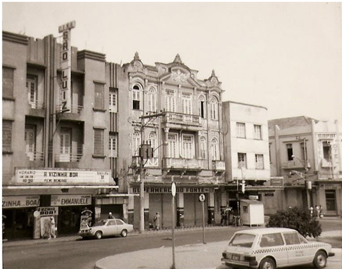
22.13. Fachada do Cine São Luiz e a Praça da Estação em 1981. Fonte: Site “ Maria do Resguardo ”. Acesso 03 abr. 2022.
