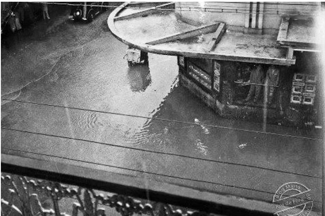
15.5. Cine Palace na enchente de 1952. Fonte: Site " Maria do Resguardo ", acesso 03 abr. 2022.
