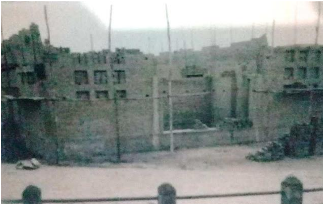
25.6. Cine Benfica (talvez aqui apenas Paróquia Pio XI) em construção, fachada, talvez na década de 1940. Fonte: Site “ Maurício Resgatando o Passado ”. Acesso 04 abr. 2022.
