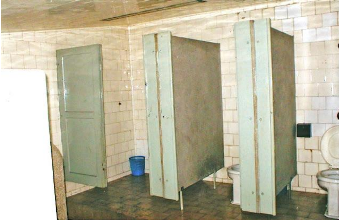
24.15. Excelsior em 2003 sanitário masculino. Fonte: Site " Maria do Resguardo ". Acesso 03 abr. 2022.
