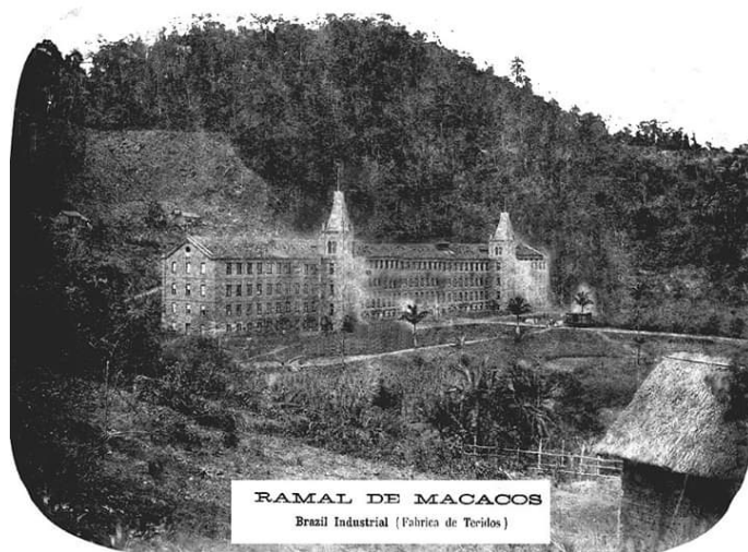
Figura 1: Brazil Industrial | Fábrica de tecidos. Ramal de Macacos, RJ: 1881.
