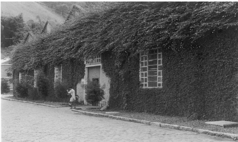
Figura 19: Antigo prédio da Tecelagem da Fábrica Maria Cândida
