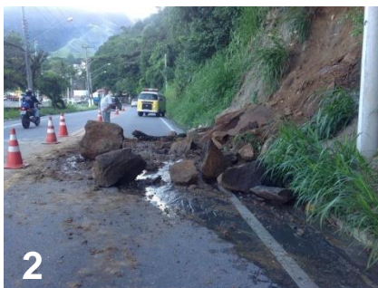
Figuras 2 e 3 – Talude rompido no km 119 - março de 2015. (Portal G1, 2015; Folha do Litoral Norte, 2015a).
