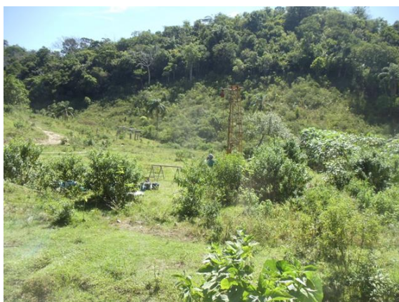
Figura 6 – Vista geral da área de transposição da OAE 221. Notar a SR-21C-103 na estaca 2834. Ao fundo o encontro E1.
