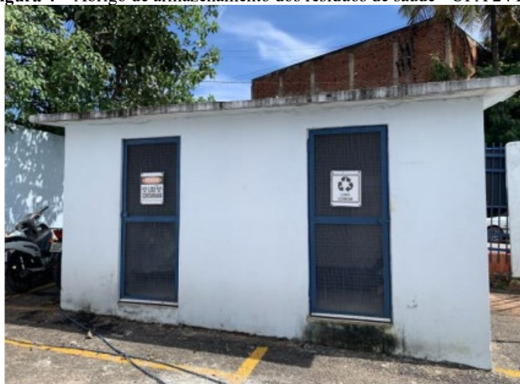
Figura 4 – Abrigo de armazenamento dos resíduos de saúde - UPA 24 HS.
