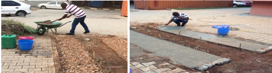
Figura 1: Compactação do local da experiência e construção dos alicerces.
