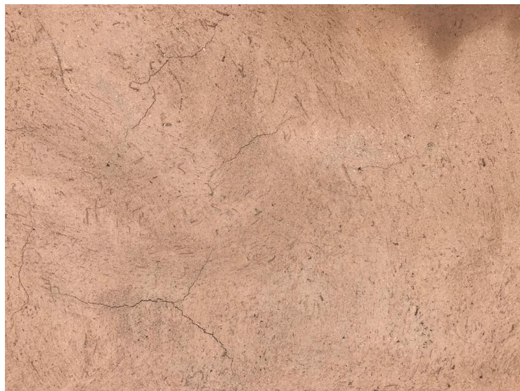
Figura 08 – Alvenaria produzida apenas com agregados reciclados.
