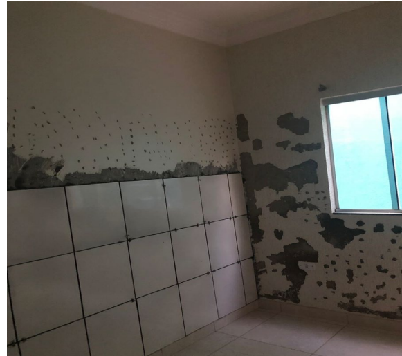
Figura 13: Aplicação do revestimento
