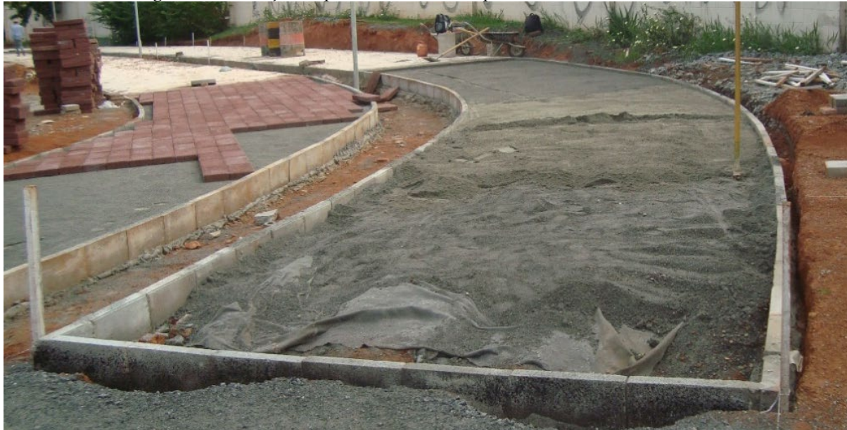
Figura 1 – Execução do piso drenante no Parque Linear Macambira Anicuns
