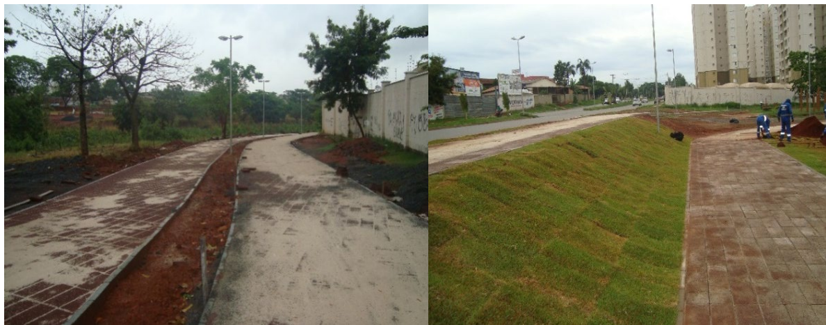
Figura 2 – Execução do piso drenante no Parque Linear Macambira Anicuns
