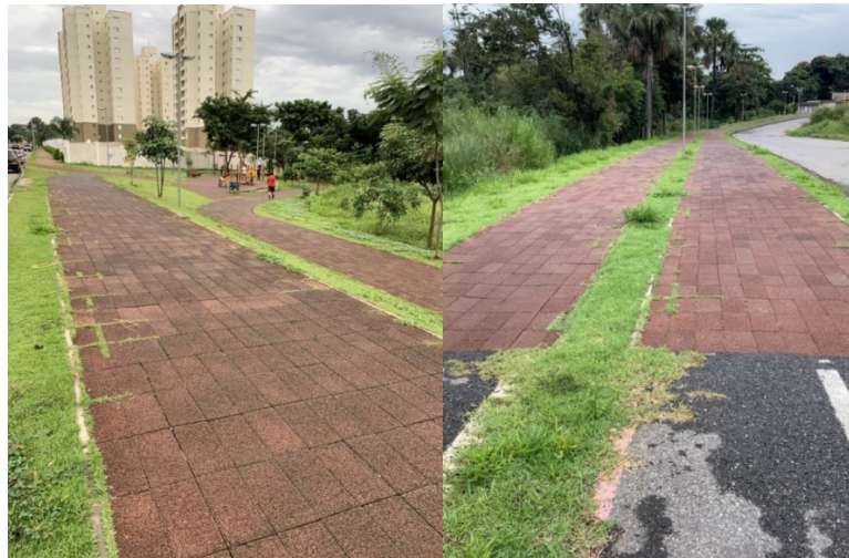
Figura 3 – Piso drenante no Parque Linear Macambira Anicuns
