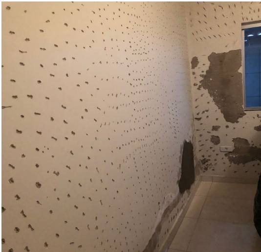
Figura 12: Parede picotada
