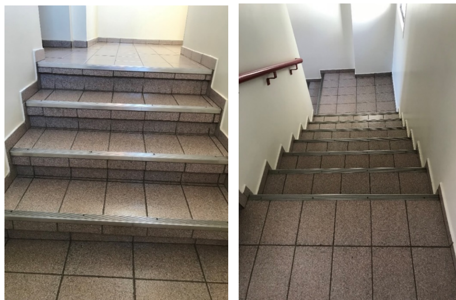
Figura 9 –Escada de emergência
