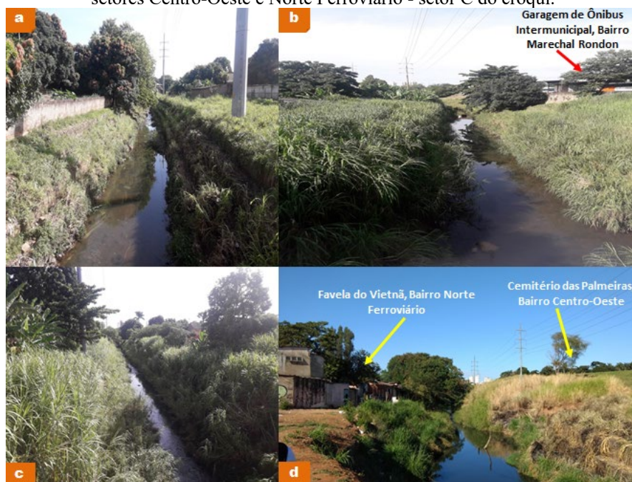
Figura 8: Visão do Córrego Capim Puba a partir das avenidas Marechal Rondon (a, b, c) e Goiás (d) entre os setores Centro-Oeste e Norte Ferroviário - setor C do croqui.
