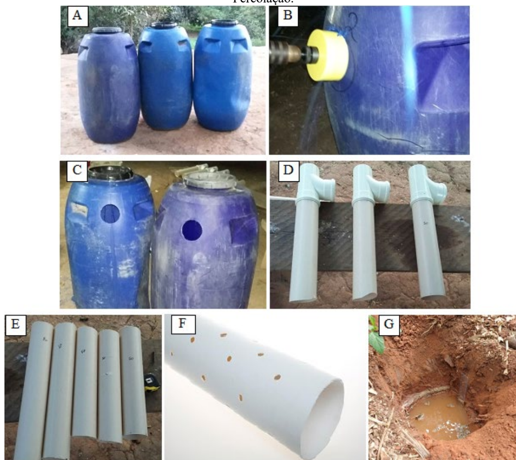
Figura 05: Pré-instalação do TSE e preparação de material de instalação. (A – C) Bombonas e processo de preparação; (D – F) Tubulação: Sifão Invertido; Conectores; Tubo para Vala de Infiltração; (G) Teste de Percolação.
