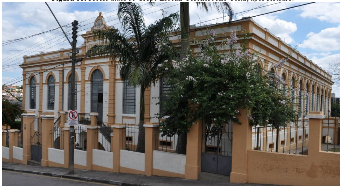
Figura 06: Prédio atual do Grupo Escolar Coronel Júlio César, após restauro.
