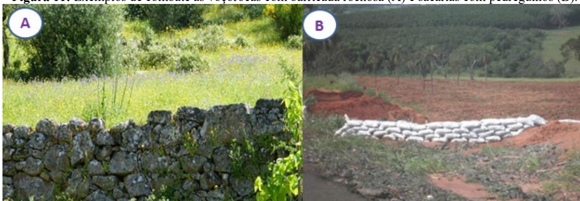
Figura 11: Exemplos de combate às voçorocas com barricada rochosa (A) e sacarias com pedregulhos (B).
