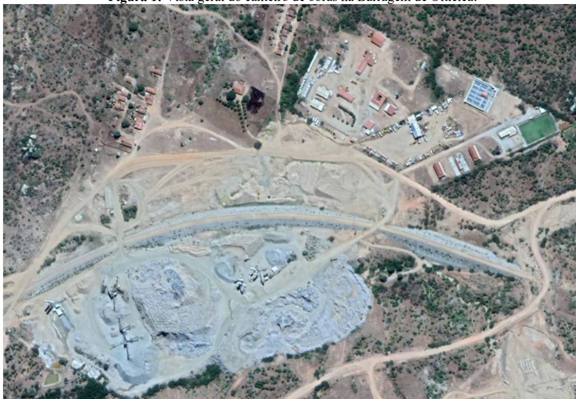
Figura 1: Vista geral do canteiro de obras na Barragem de Oiticica.
