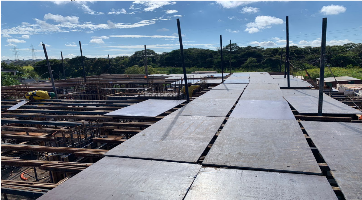
Figura 14: Cimbramento - Sistema Convencional com Torres – Assoalho.
