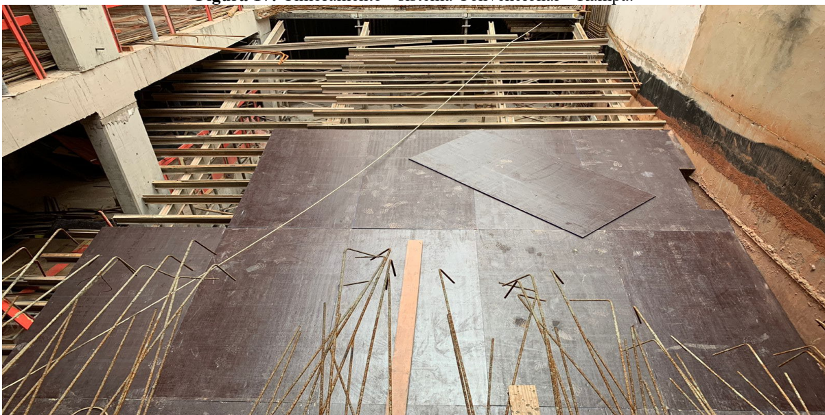
Figura 17: Cimbramento - sistema Convencional – Rampa.
