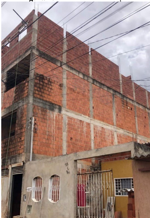
Figura 1: Alvenaria de Vedação.
