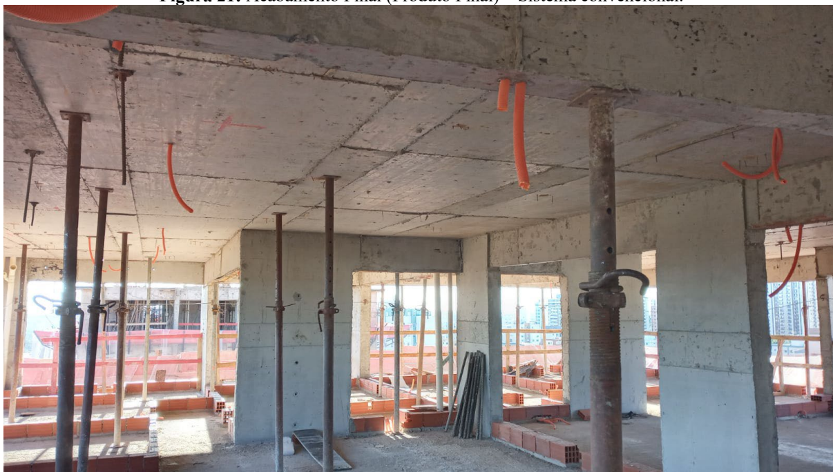
Figura 21: Acabamento Final (Produto Final) – Sistema convencional.
