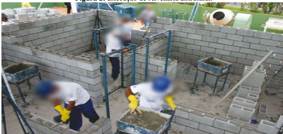
Figura 2: Execução de Alvenaria Estrutural.
