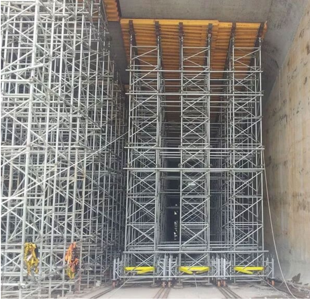
Figura 11: Cimbramento - Sistema Convencional.
