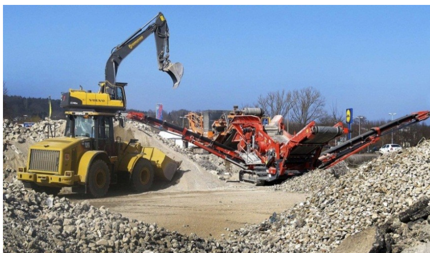
Figura 4. Tratamento dos resíduos sólidos da construção civil
