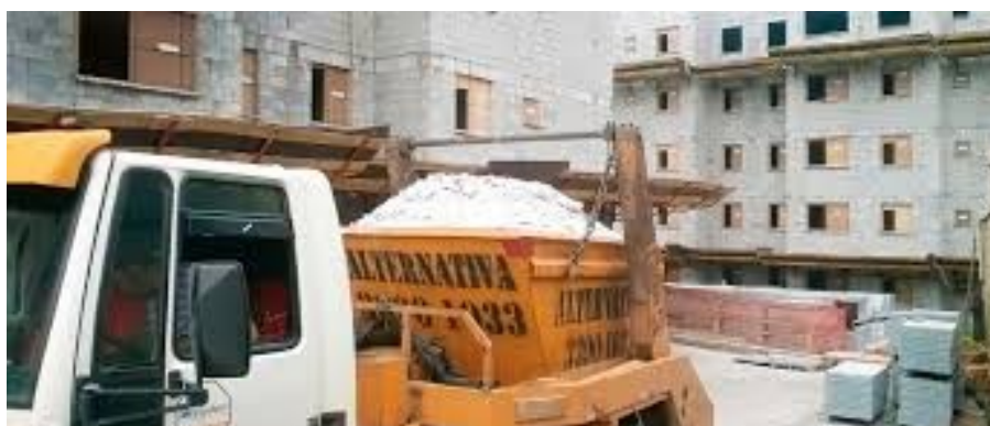
Figura 3. Transporte de resíduos sólidos da construção civil
