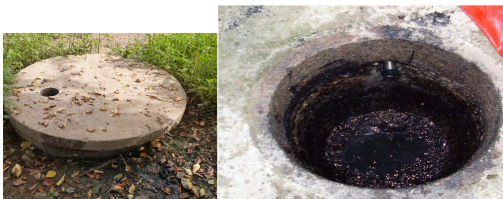
Figura 3. Fossa Negra/Rudimentar fechada e aberta.
