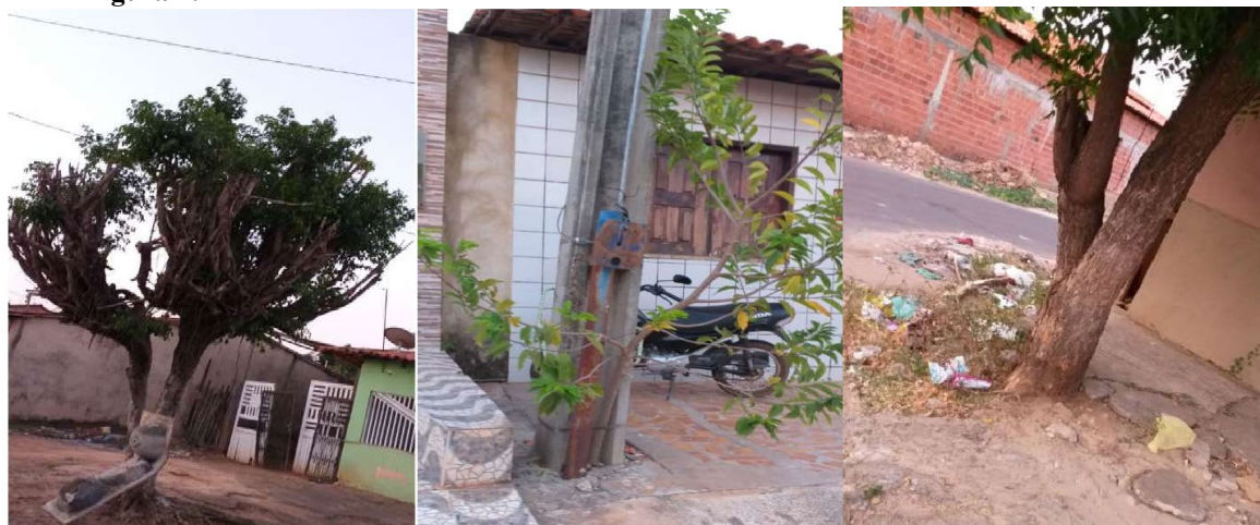
Figura 4: Conflitos vistos entre as árvores e infraestrutura urbana na Rua Adalberto de Macedo
