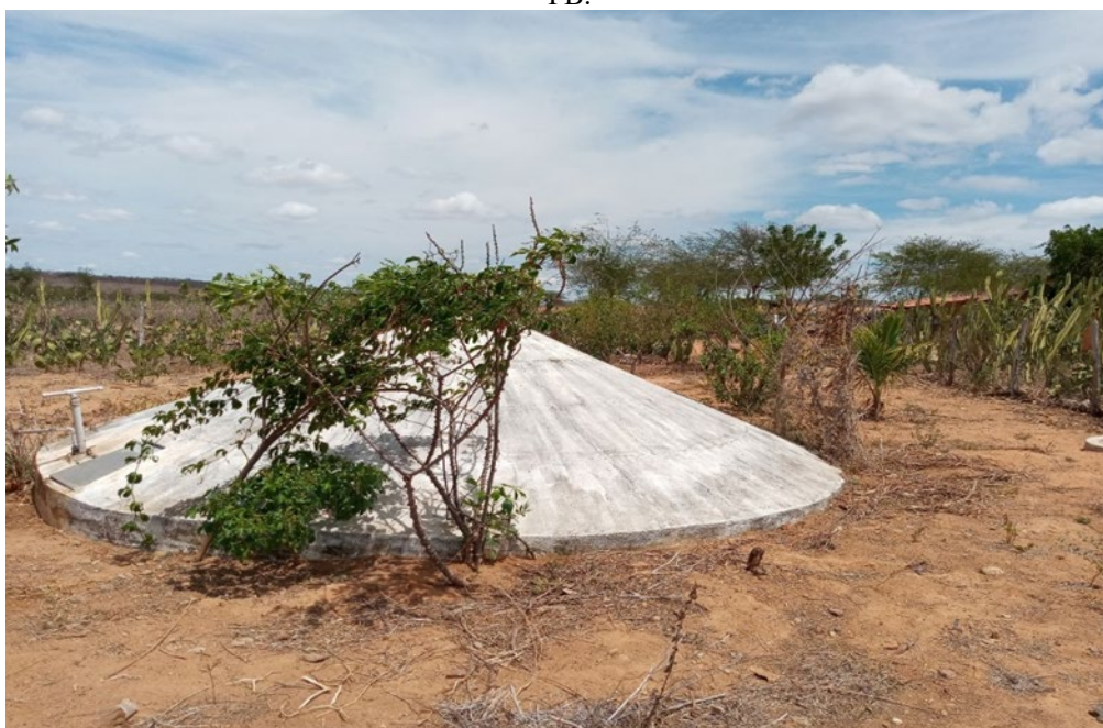
Figura 1: Cisterna usada na captação da água da chuva no assentamento São Domingos no município de Cubati – PB.
