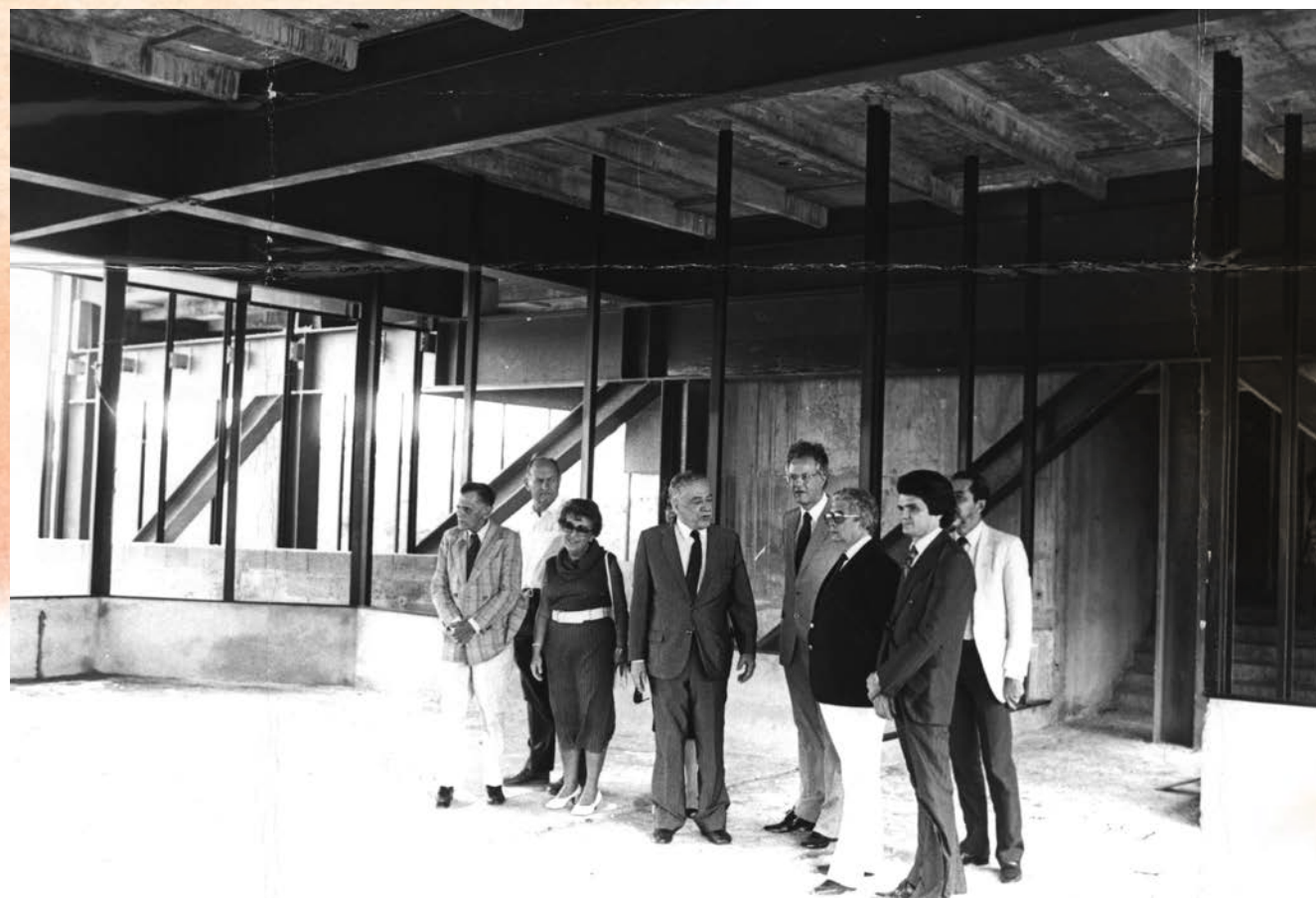
Em visita às obras de construção da Casa do Comércio
