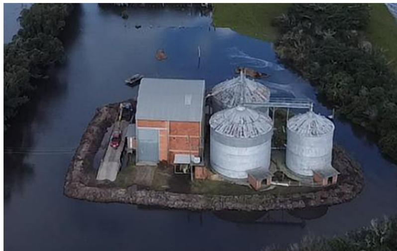
Criação de barreiras físicas de contenção, para proteção de silos
