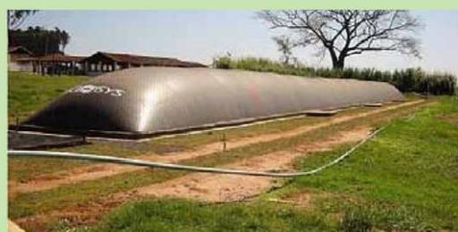
O biodigestor é uma solução econômica e ambiental ao mesmo tempo, uma vez que resolve o problema da disposição dos dejetos dos animais e ainda gera energia suficiente para o consumo e funcionamento da propriedade. Esses biodigestores irão,
