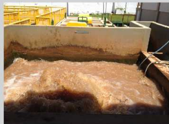
Estação de tratamento de Ceres
