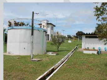
Estação de tratamento de água de Hidrolândia
