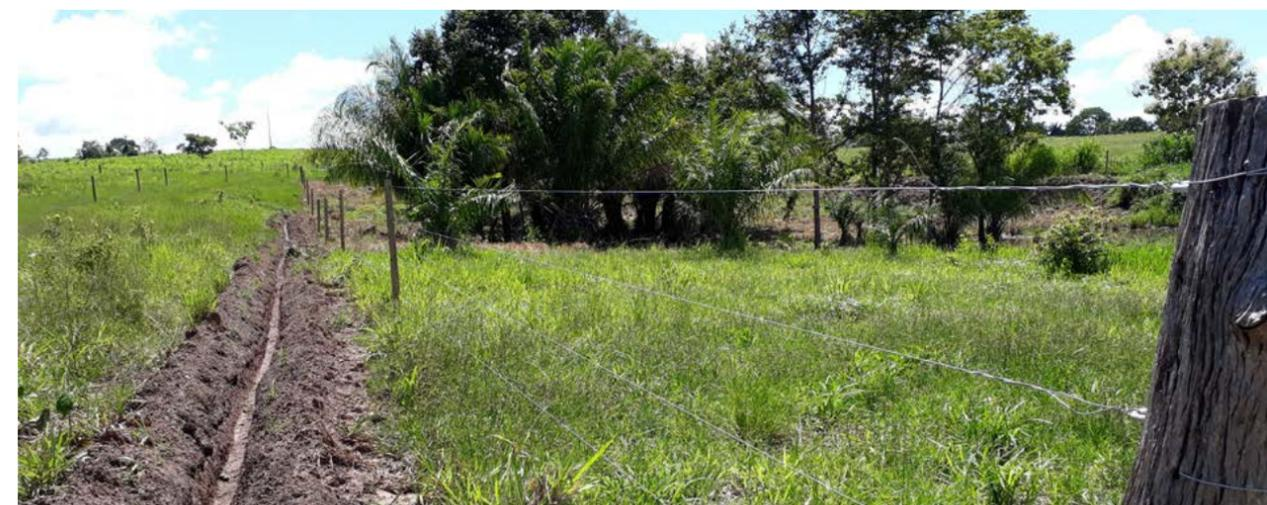
Figura 7 – Construção de terraço para contenção da água de enxurrada em propriedade rural no município de Rolim de Moura/RO.
