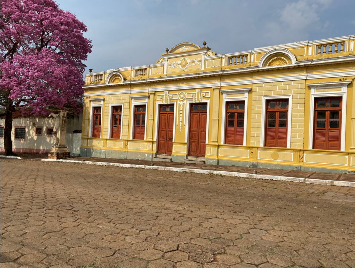
[Figura 1] Vista frontal do prédio que abriga o Museu de Arte Pantaneira “Manoel Antônio Paes de Barros”
