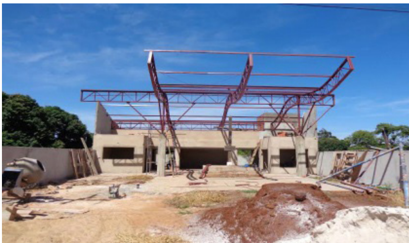
Construção do Museu da CAND
