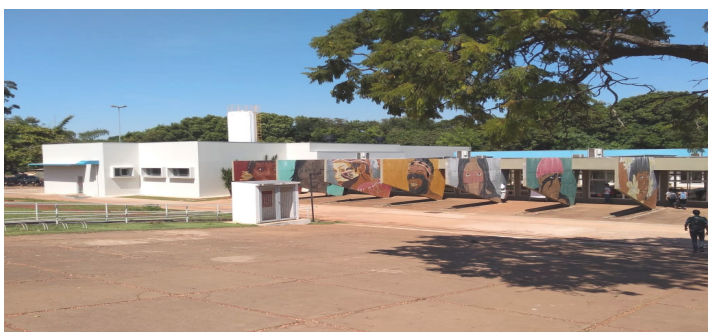
[Figura 6] Restaurante Universitário, UFMS, depois das intervenções, Campo Grande, MS, ano 2019.
