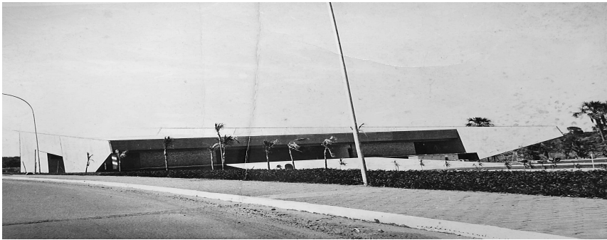
[Figura 7] Fachada principal Teatro Glauce Rocha, conclusão da obra, Campo Grande, MS, ano 1971.
