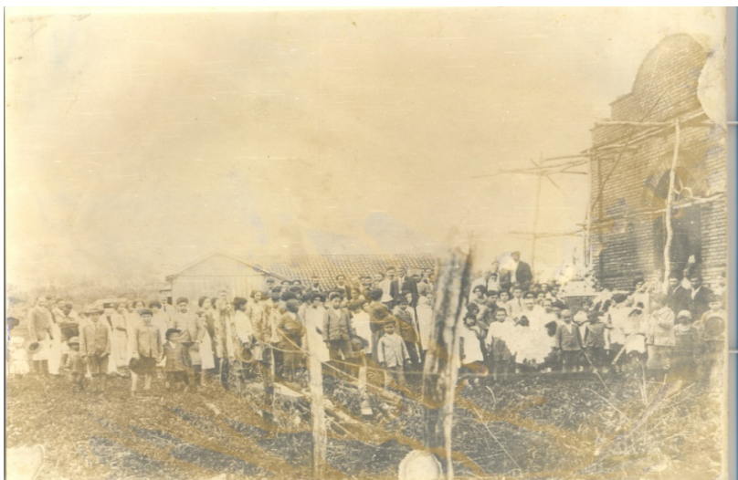
[Fotografia 1 ] Capela em construção
