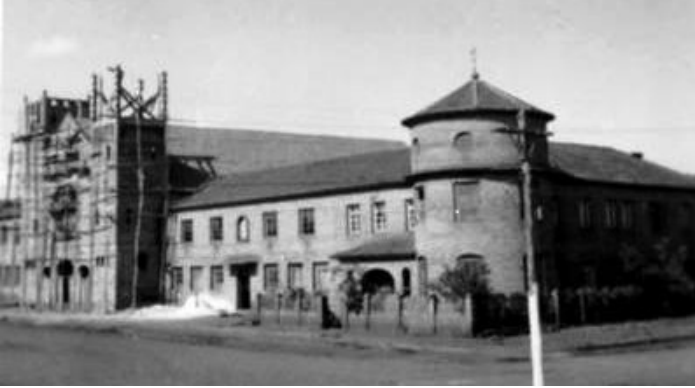
[Fotografia 7] Construção da Catedral Imaculada Conceição
