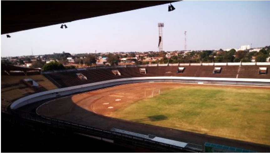
[Figura 14] Vista interna das arquibancadas descobertas e campo. Estádio Pedro Pedrossian – Moreirão – Campo Grande, MS, ano 2019.
