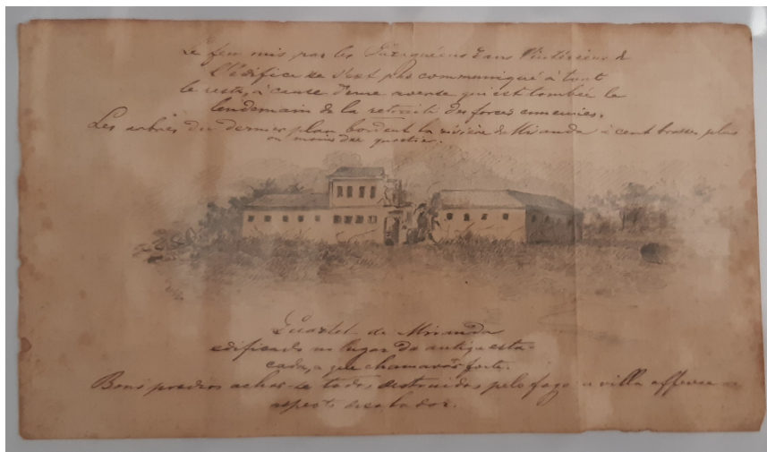
[Imagem 2] Croqui da fachada do Presídio de Miranda.
