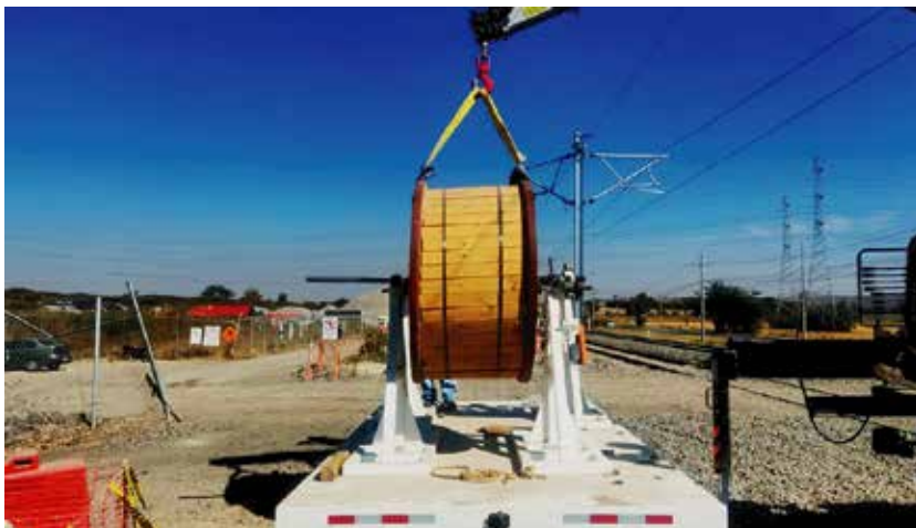
Foto en Aeropuerto Intl de Gdl de 2024, Modelo EE294, RHINO SLINGS para 10.1T canasta a 90°
