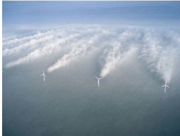
Figura 3.7: Efecto estela en aerogeneradores.
