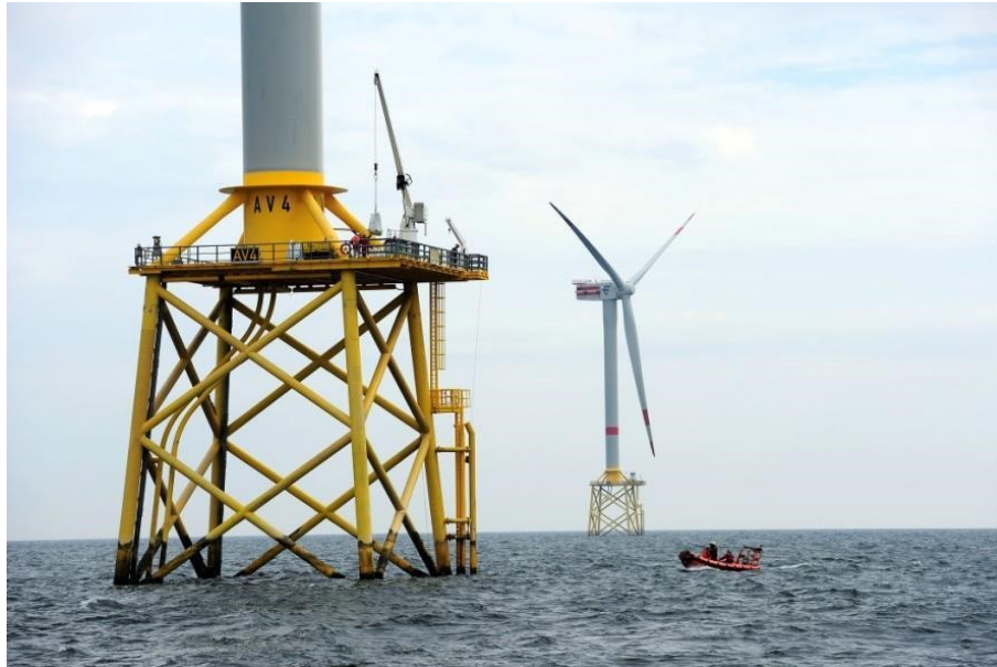
Figura 3.4: Cimentación Jacket.
