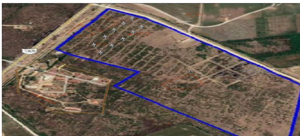
Figura 3.11. Distribución de los aerogeneradores Enair 200.
