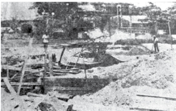
Figura 10: Obras da galeria extravasadora, 1973
