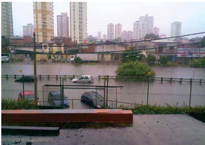
Figura 2: margens e entorno do Canal urbano da Trav. Três de Maio.
