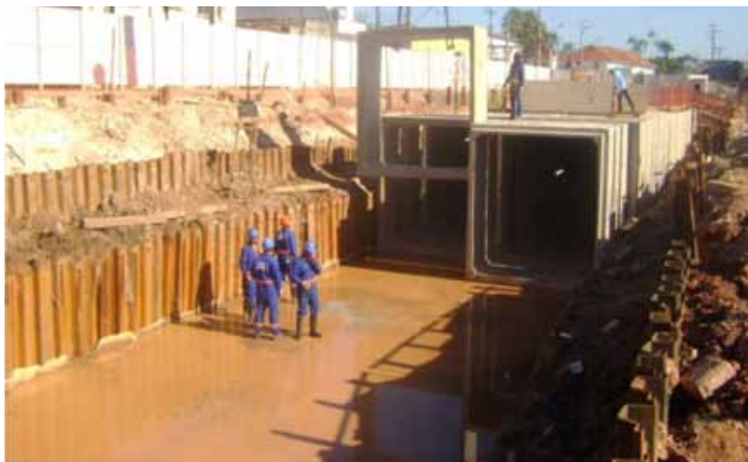
Figura 7 - Construção da galeria da Av. Bernardo Sayão.
