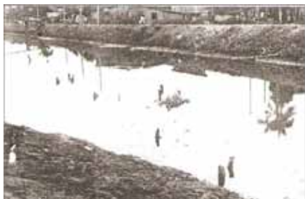
Figura 1 - Foto do entorno da Unama Campus Alcindo Cacela antes de receber o sistema de macrodrenagem.
