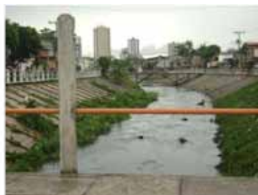
Figura 2: Foto do sistema de macrodrenagem do entorno da Unama Campus Alcindo Cacela.
