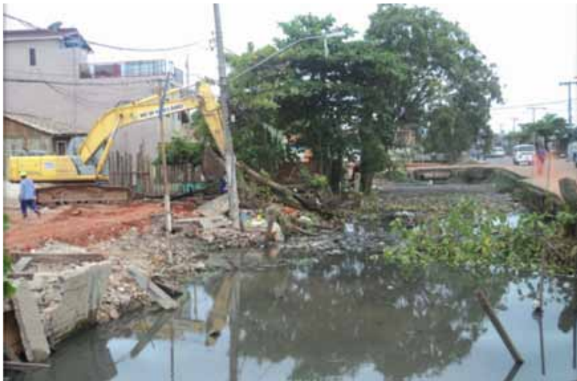
Figura 6 - Canal da Av. Bernardo Sayão.
