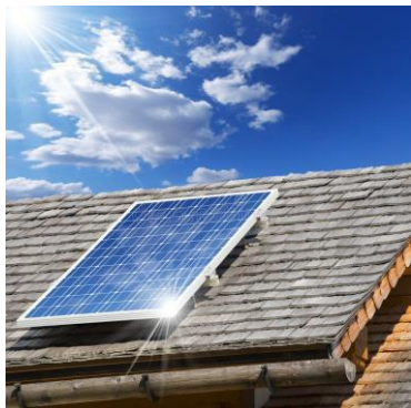
Panneau solaire sur le toit
