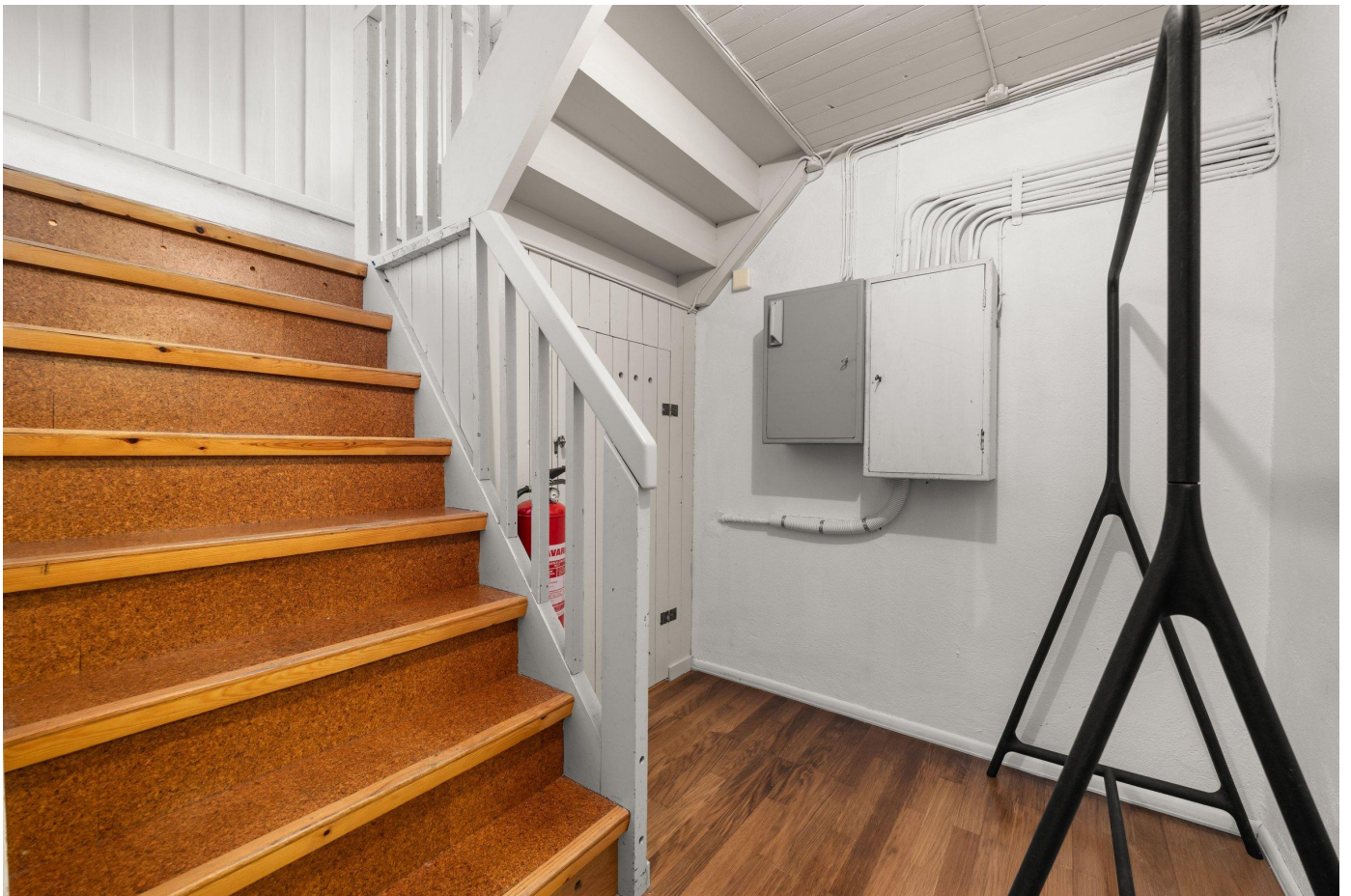
Trapperom i kjeller med bod under trapp
