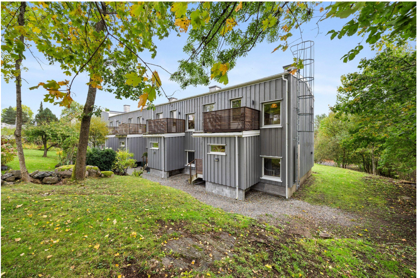
Inngangsparti tilbygget i 2017. Etterisolering og ny kledning fra samme år.
