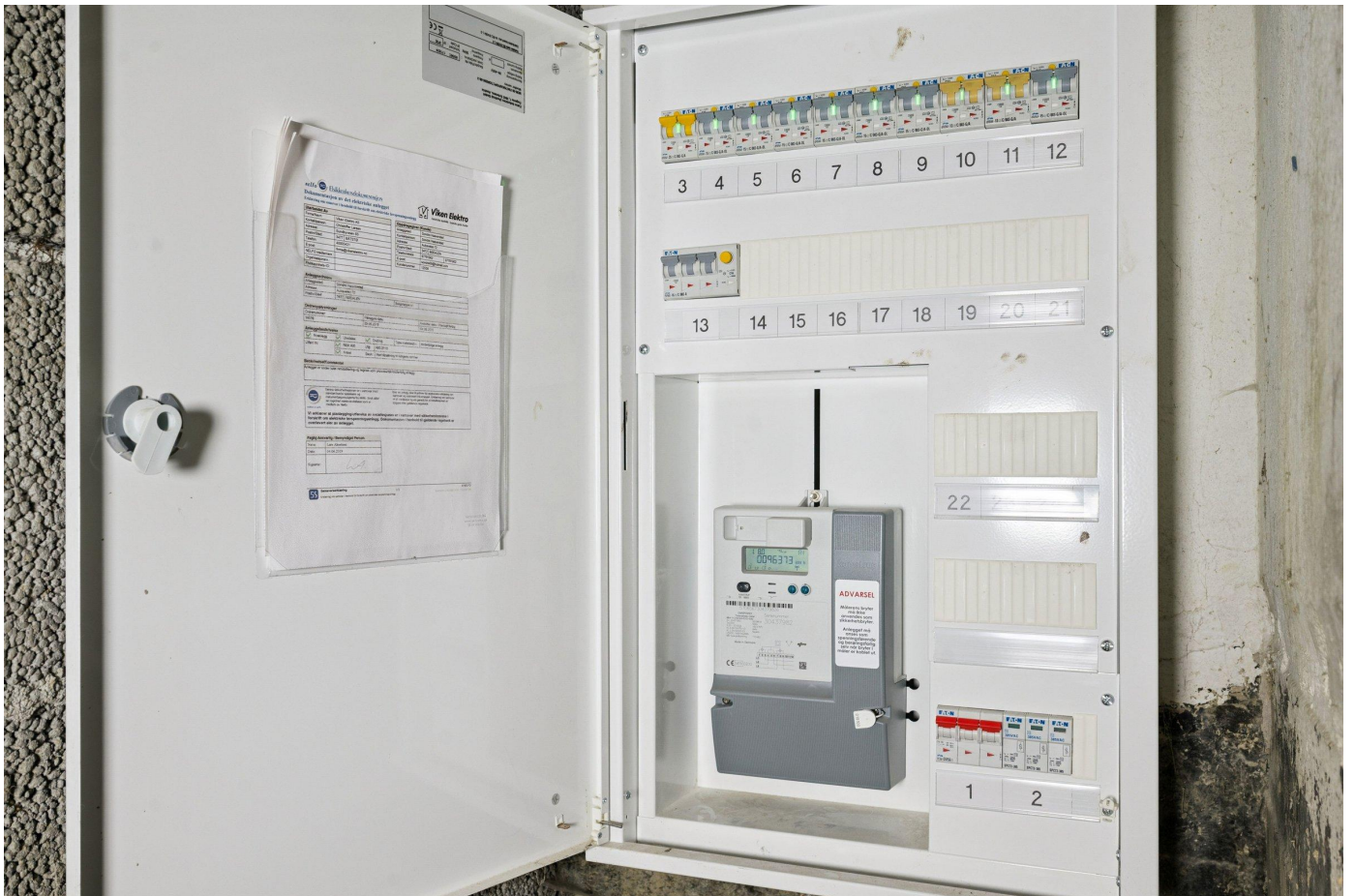
Nytt sikringskap i kjeller
