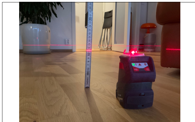
Nivellering av gulv. Kontroll av helling.
