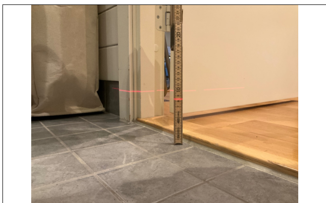
Kontroll av fall til sluk.
