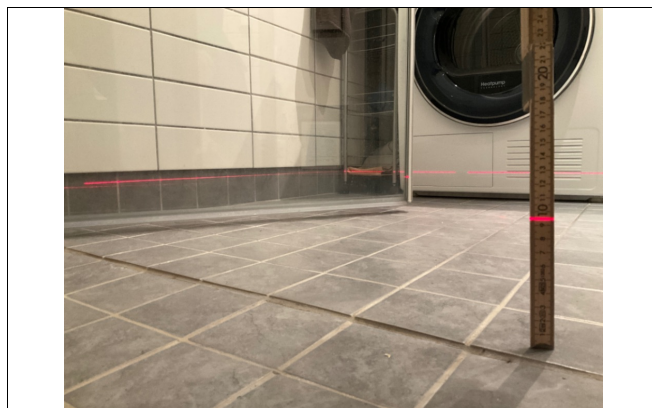
Kontroll av fall til sluk.
