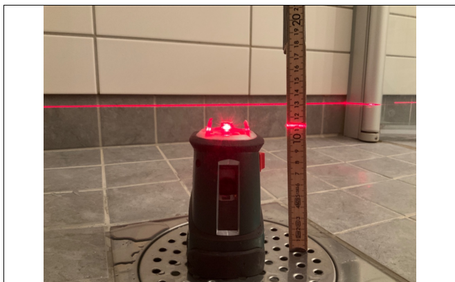
Kontroll av fall til sluk
