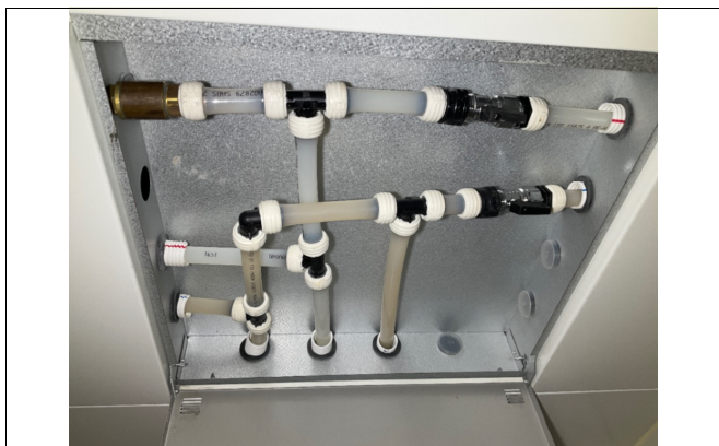
Kontroll av rørskap i tak på bad.
