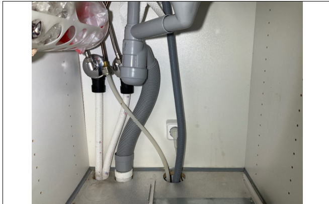
Kontroll av røropplegg i kjøkkenbenk.
