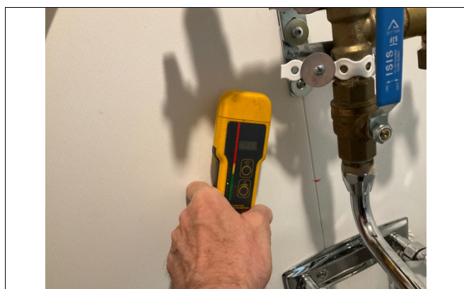
Kontroll søk med fuktmåler på vaskerom.
