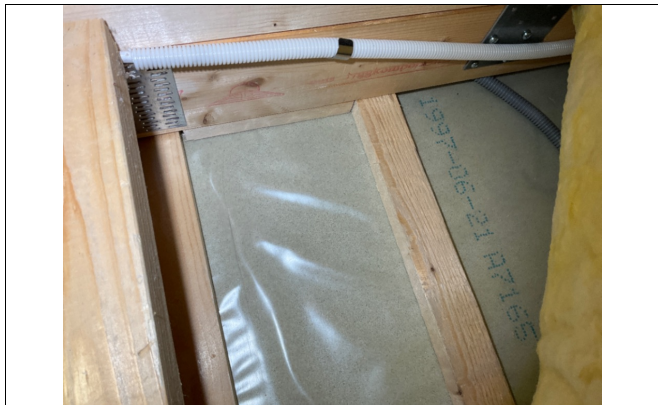
Kontroll av fuktsperre i gulv på kald loft.
