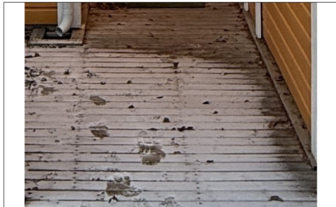
Slitte terrassebord på inngangssiden.
