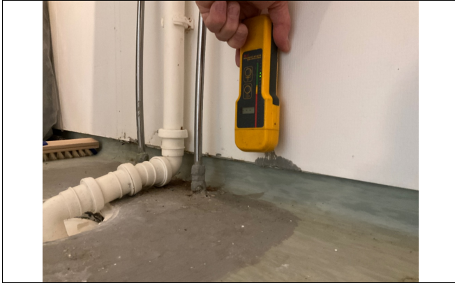
Kontrollsjøk med fuktmåler på vaskerom.
