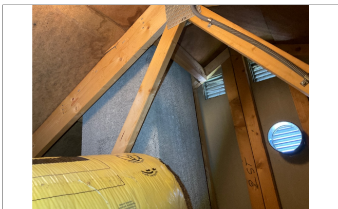
Kontroll av kald loft. Elementpipe.
