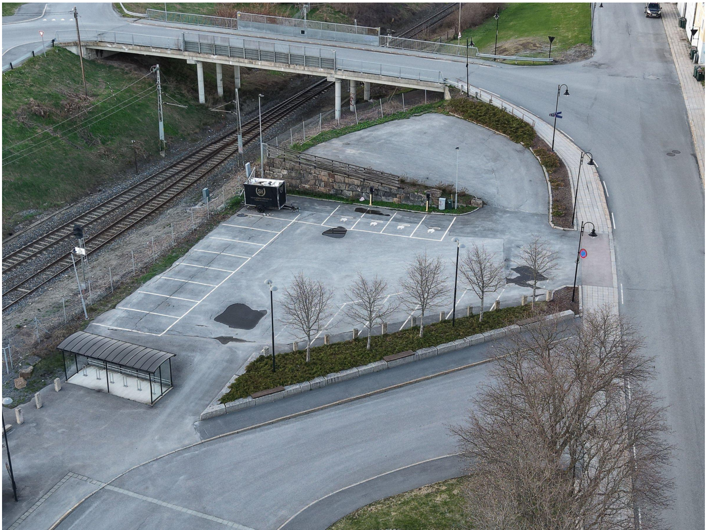
Ladestasjon for elbil rett ved.
