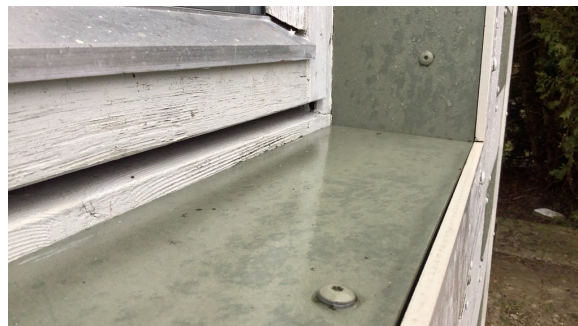
Eksempel på utett omramming.
