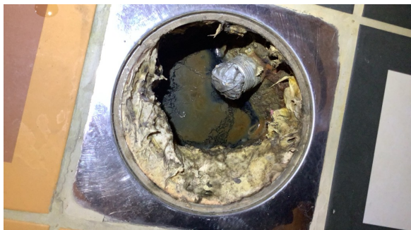
Det er ikke tegn til membran rundt sluk
