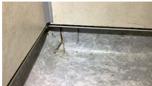
Utett hjørne i vinylbelegg.
