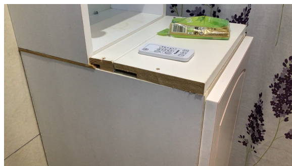
Utforinger er enkelt montert som topplate.
