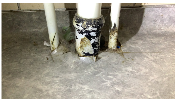
Utett gjennomføring i vinylbelegg.
