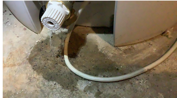
Svetting fra sikkerhetsventil/tappestuss.
