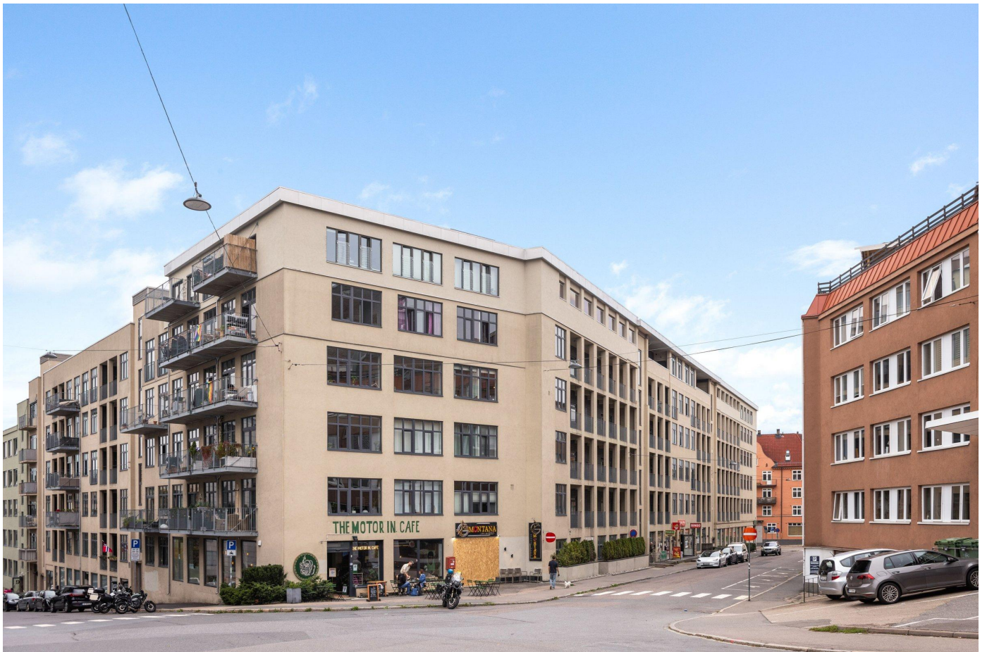
Nordøstlig fasade med inngangsparti i rolig enveiskjørt gate. Til venstre i bilde ligger innkjørsel til sameiets garasje med heis opp til leiligheten.
