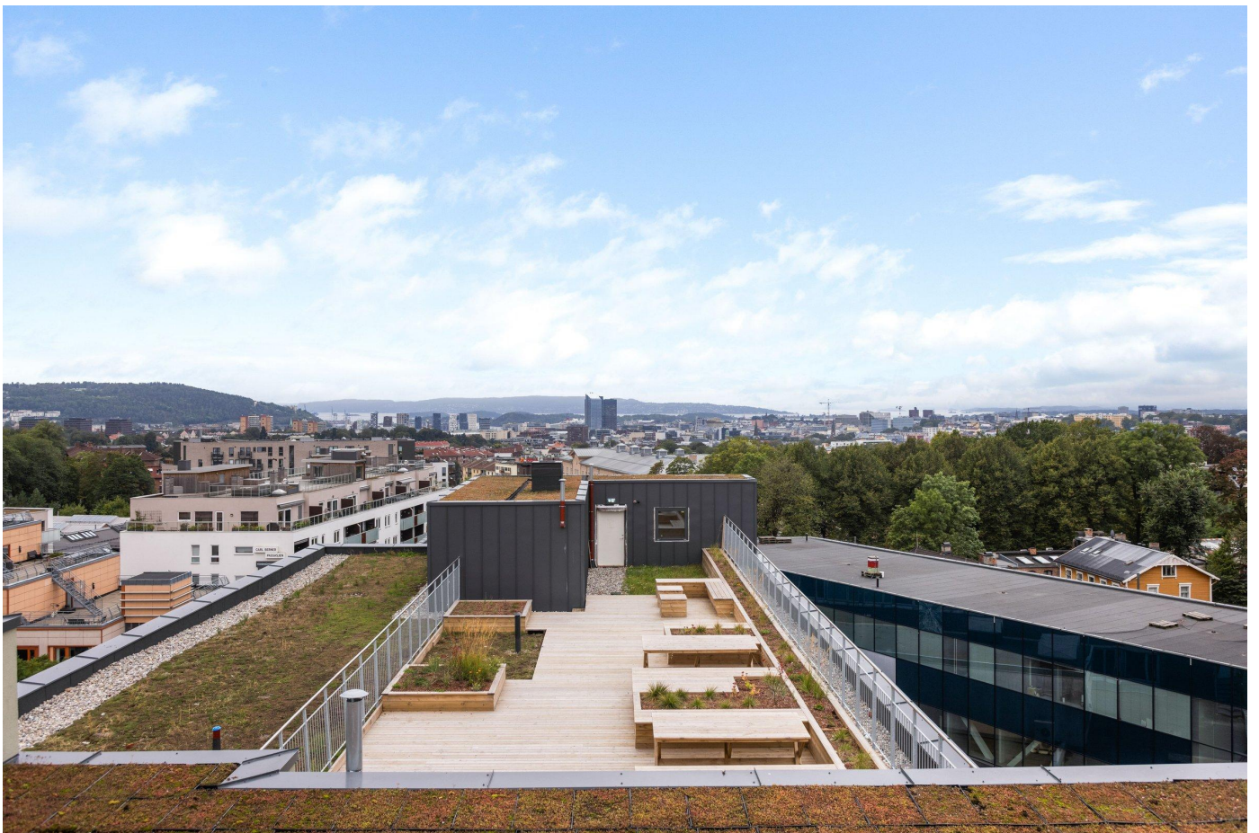
En annen felles takterrasse har tilgang via en annen oppgang.
