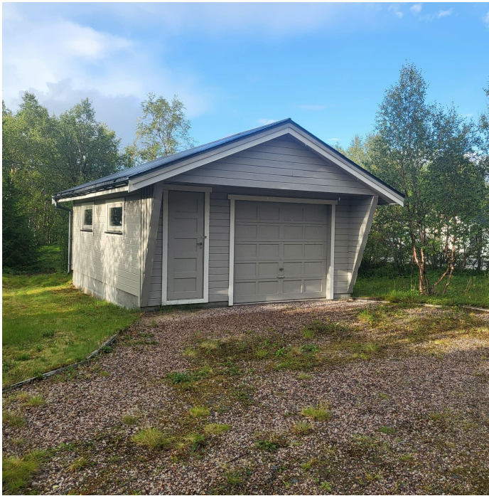
Garasje med dør og garasjeport
