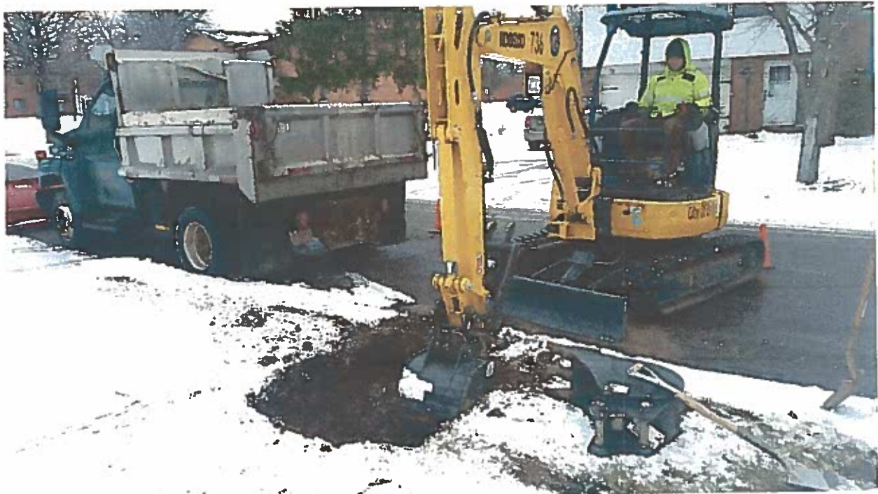
Digging a curb box with mini excavator
