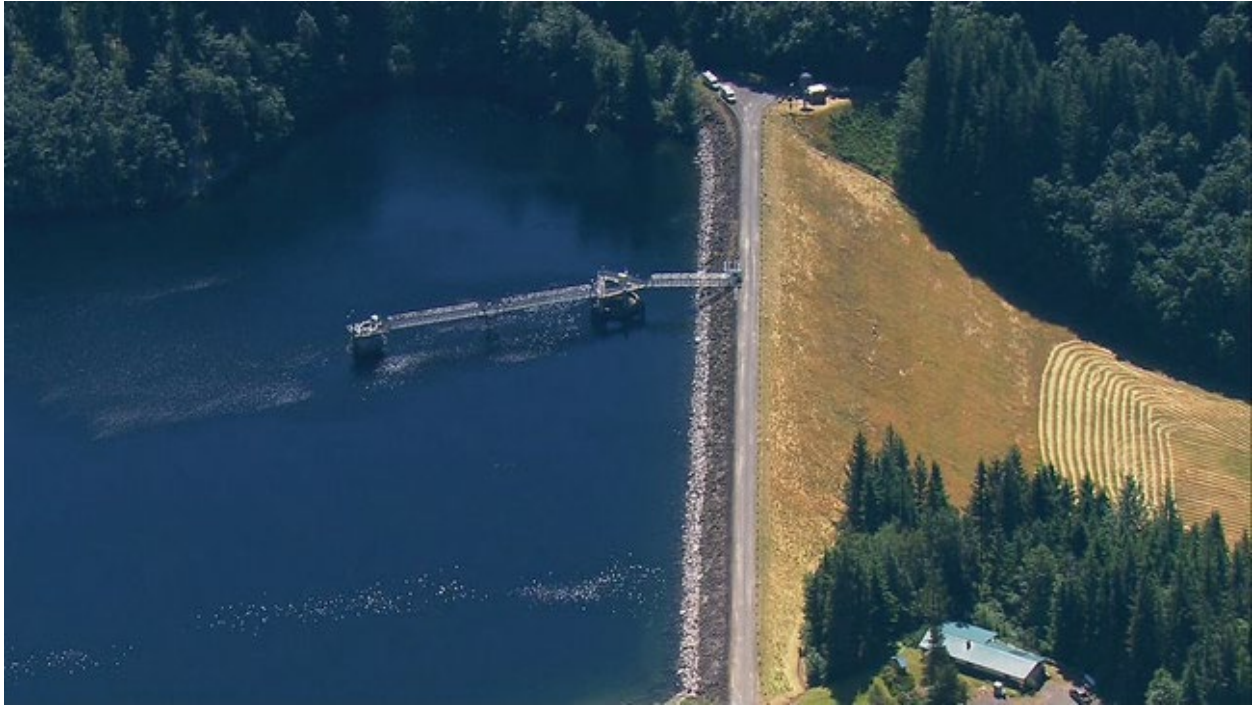
Tolt Reservoir Dam (KOMO Photo)
