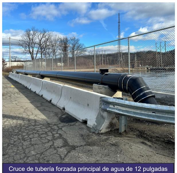
Cruce de tubería forzada principal de agua de 12 pulgadas
