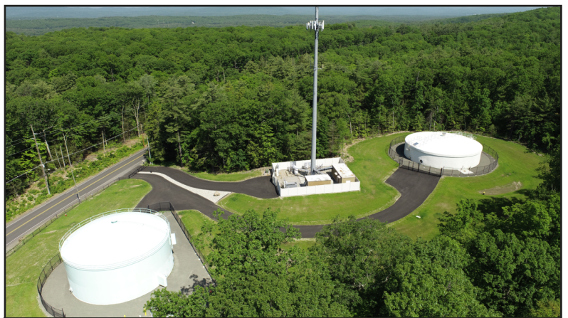
Nuevo tanque de almacenamiento de agua de concreto para complementar el tanque de acero existente.
