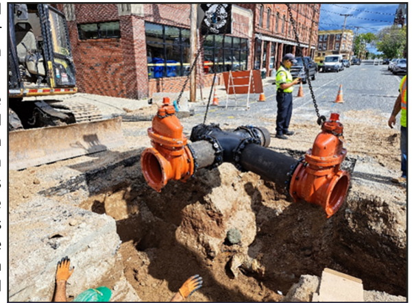
Nuevas tuberías principales de mayor capacidad para mejorar la protección contra incendios
