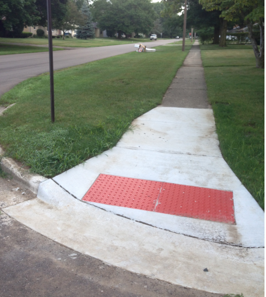
195 ADA sidewalk ramps
