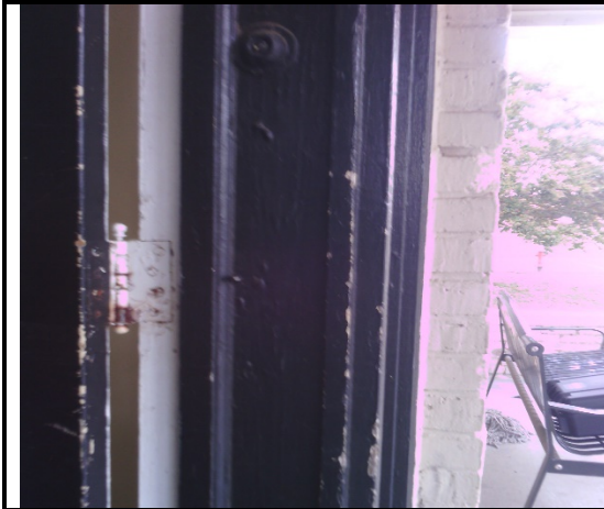
Exterior Side B Door Jamb
