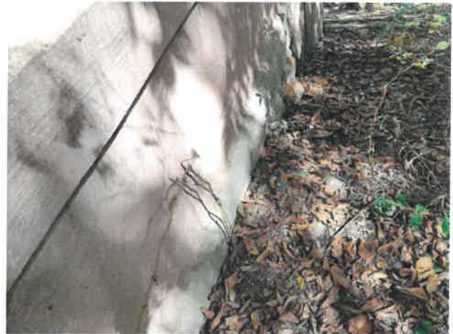
NE Corner / N. Approach Slab
