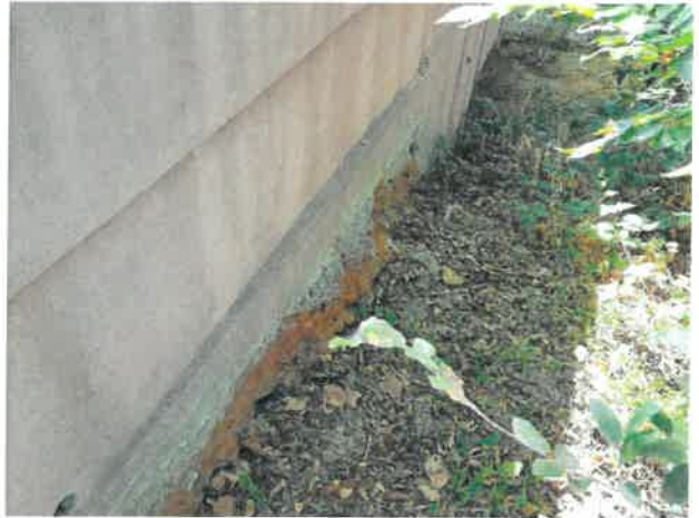
SE Corner / S. Approach Slab
