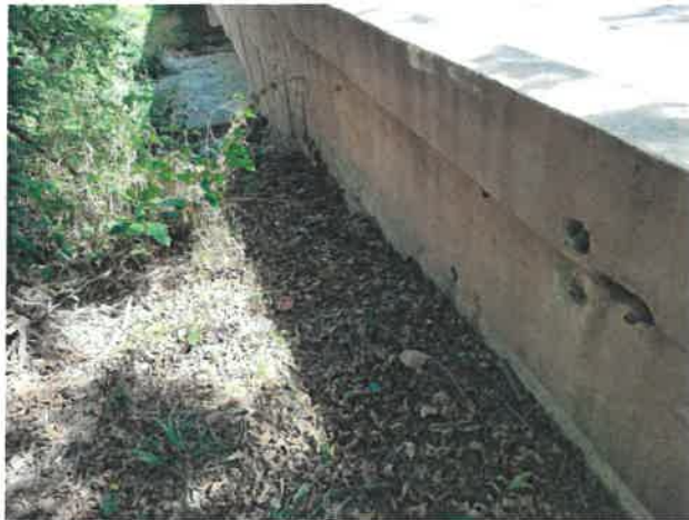
NW Corner / N. Approach Slab
